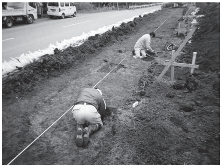
第3図 竪穴建物作業（立会調査）
