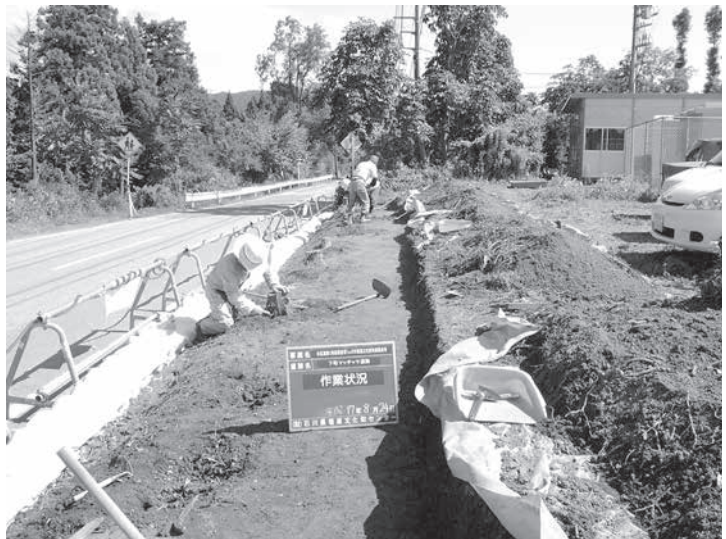
第3図 作業状況
