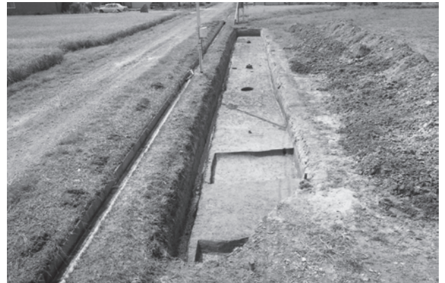
水路A区（東から）
