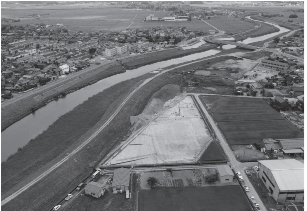
調査地上空から東方を望む（1995年撮影）
