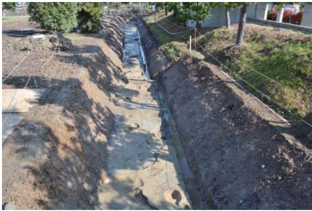
西側調査区完掘状況 (北東から)
