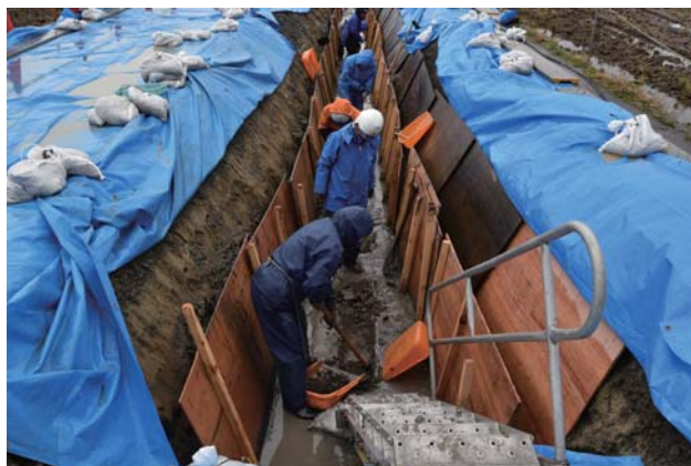
作業状況（西から）
