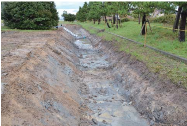
東側調査区表土除去終了 (南西から)
