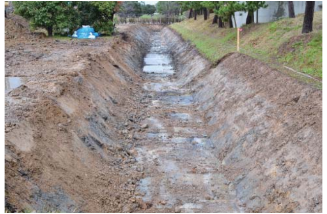
西側調査区表土除去終了状況（南西から）
