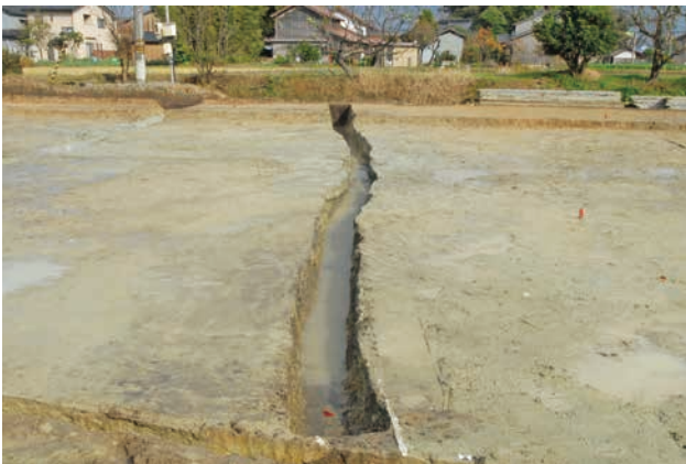
2号溝完掘状況 (南西から)
