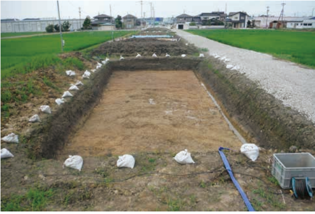
掘削終了ハ区 (南から)
