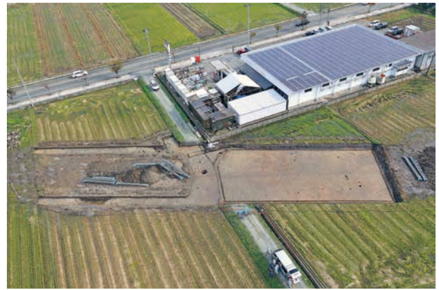
調査地遠景（第1次調査区北半部完掘時 北西から）
