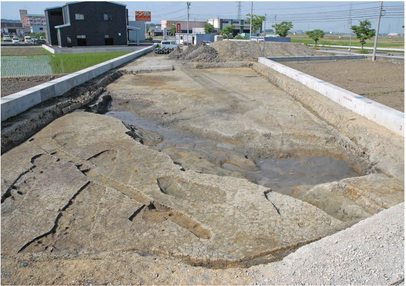
第2次調査区完掘状況（南西から）
