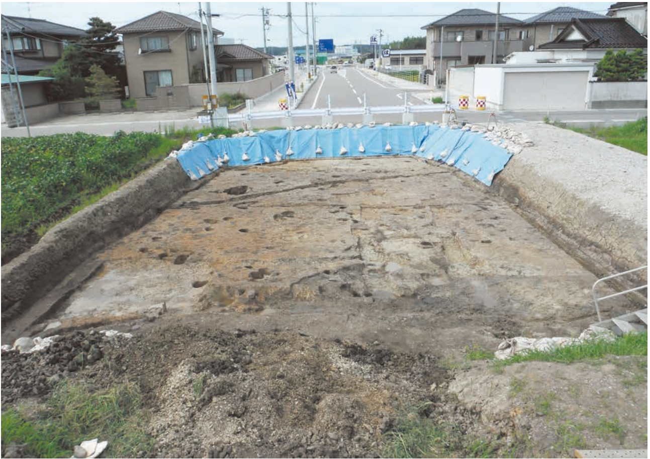
掘削終了ト区（南から）
