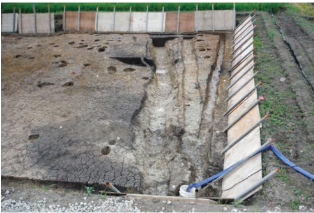
ホ区SD201・202完掘状況（東から）
