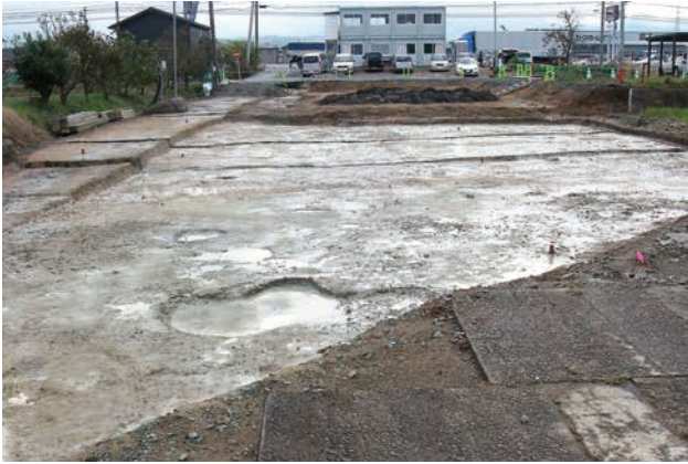
B区完掘状況（北から）
