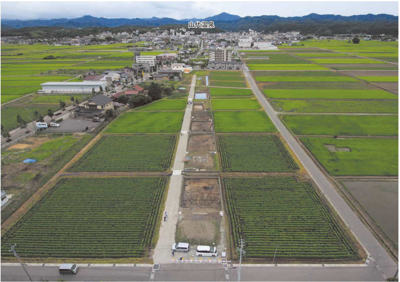
H26 調査区俯瞰 (北から)
