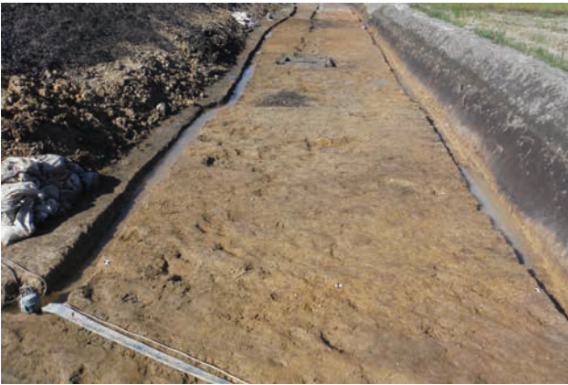
掘削終了レ区 (南から)
