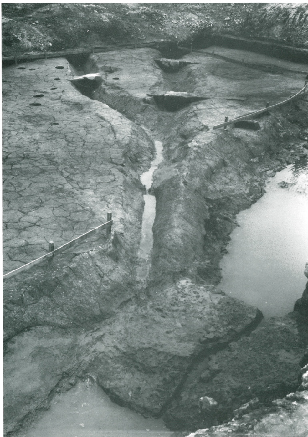
溝 S D 301,302完掘状況 (西より)
