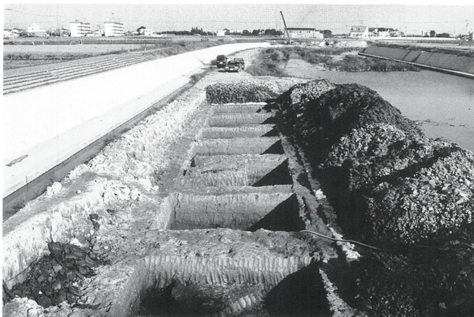
(上) 第 I 次調査左岸側調査風景 (下) 第 I 次調査左岸側完成掘状況
