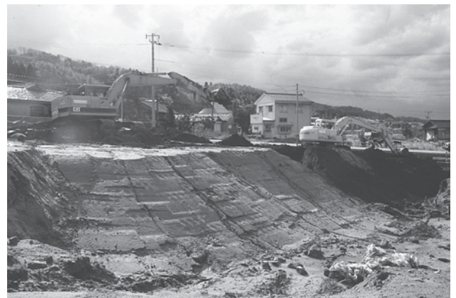
調査区埋め戻し作業風景(北西から)
