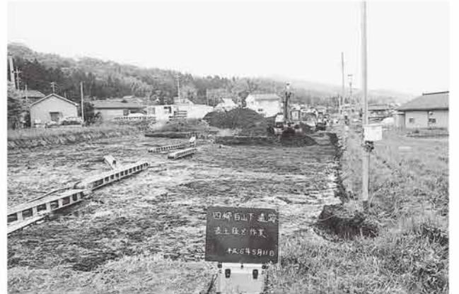
A・B地区表土除去作業（北から）
