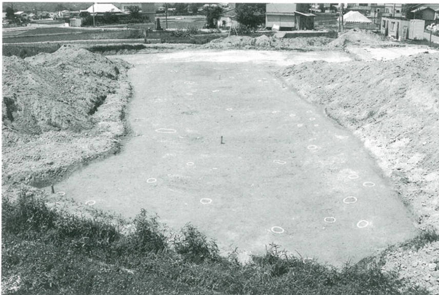
南部遺構面 検出状況
