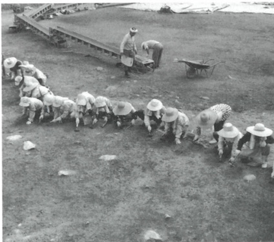
C区作業風景 西より
