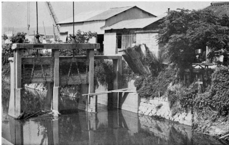
恩智川戸堰 (宇河32の西)
