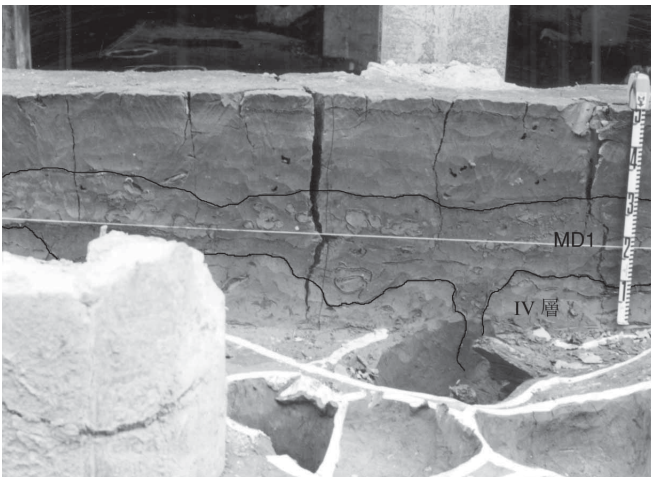
図3.8 中央南北断面 .MD1付近 .細かくちぎれた白い泥が水平方向に並ぶところがMD1の盛土 .
