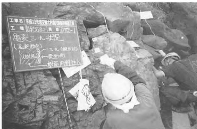
風化防止の最新技術を用いて横穴群の掘られた岩盤を保存する。
