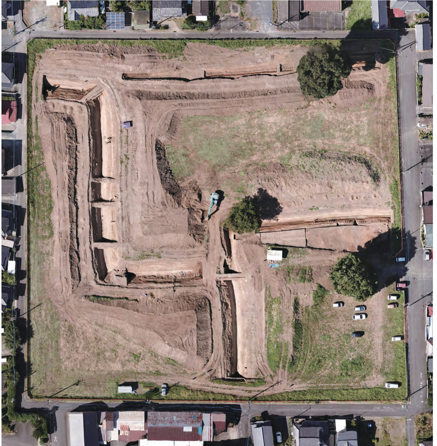
太田城跡 JT 敷地内調査区全景（真上から）
