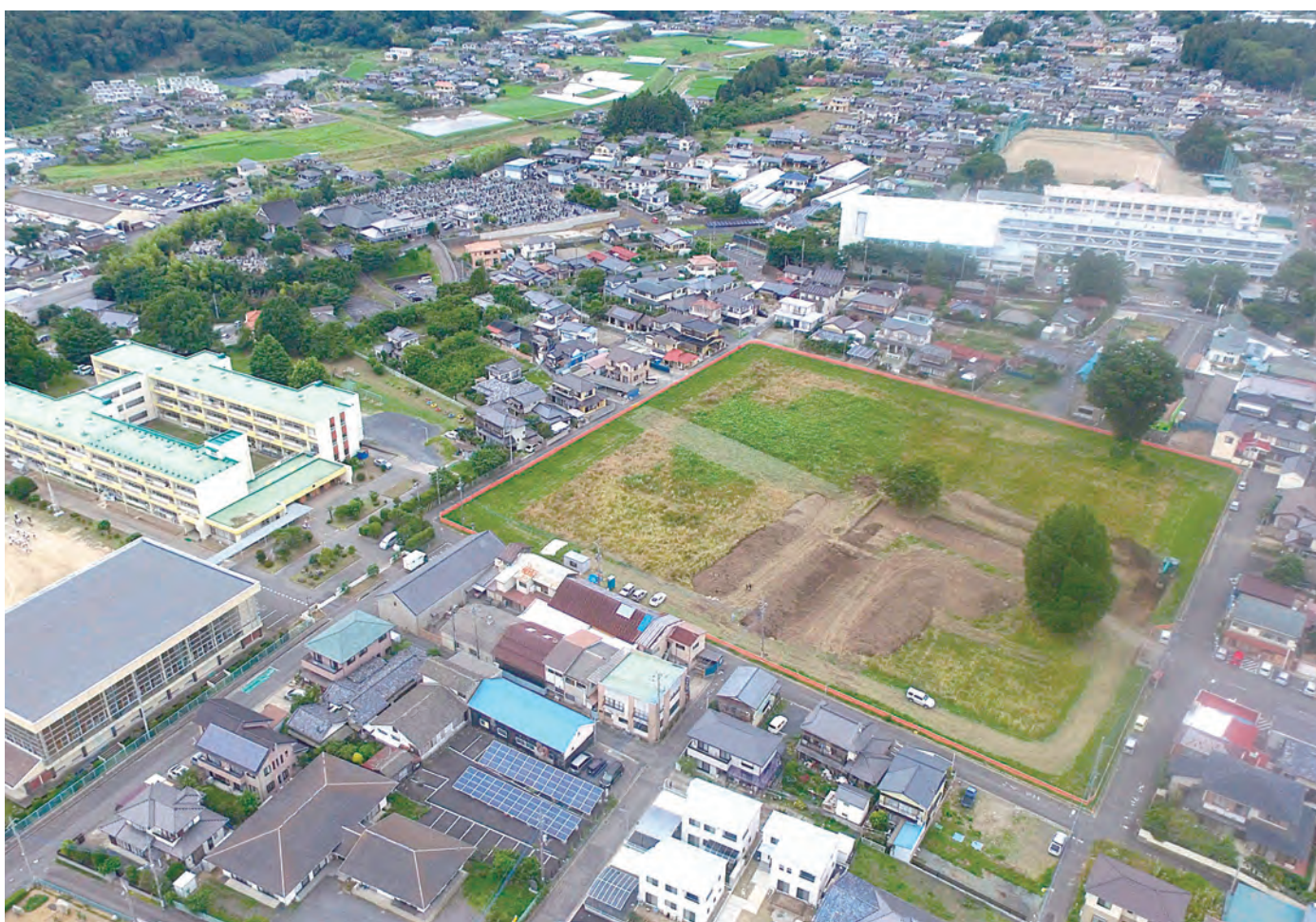
調査前状況（南上空から）
