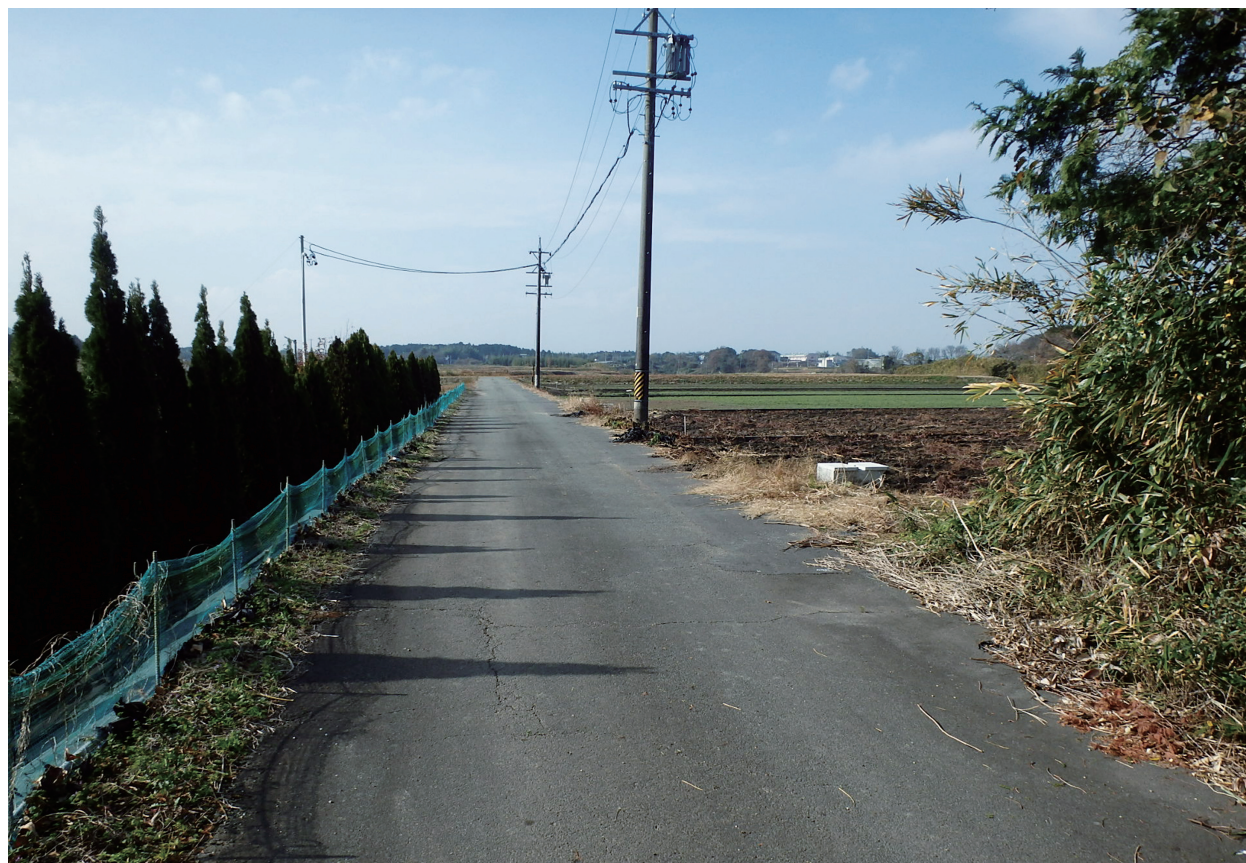
工事施工後の状況（東から）
