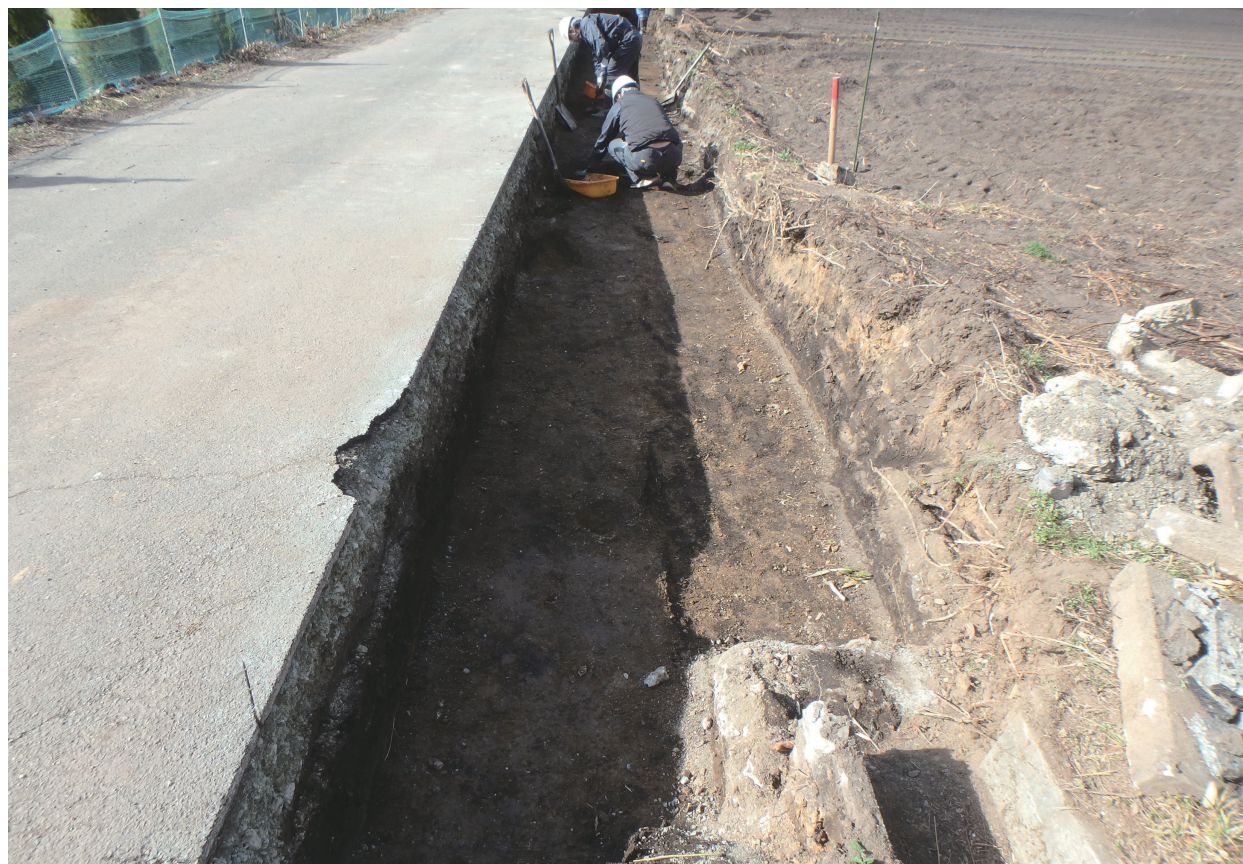
調査区東端の掘削状況（東から）
