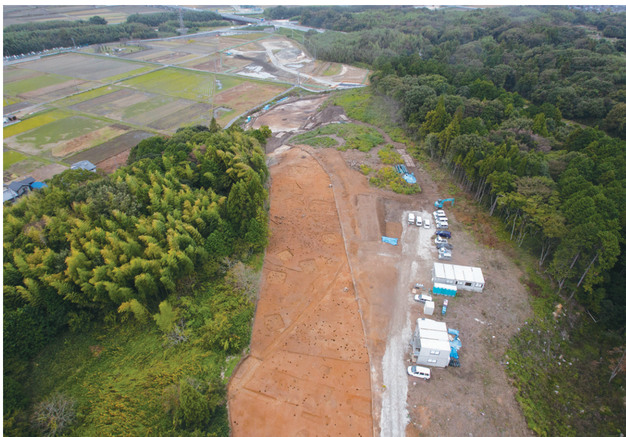
第2次調査区全景（上空東から）
