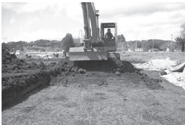
写真10 表土掘削作業（5区）
