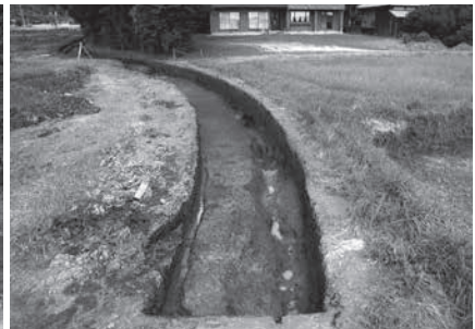
5. SD93 溝跡 完掘状況 (南部・南から)
