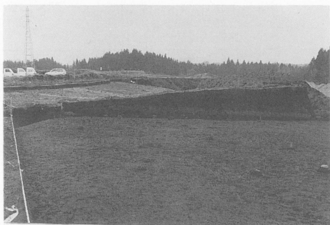
B地区1号畦畔 (東から)
