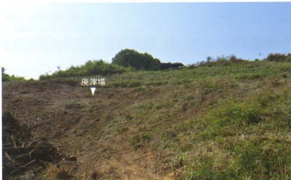
写真 170 調査着手前（南斜面）
