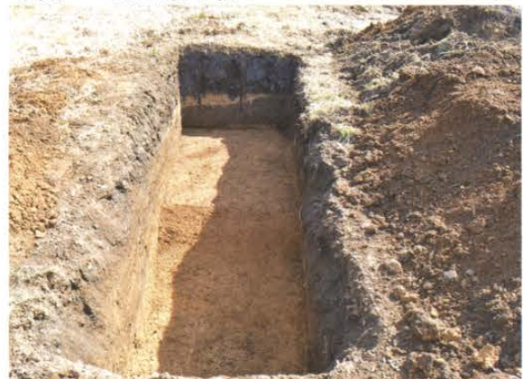
写真27 2T 調査状況
