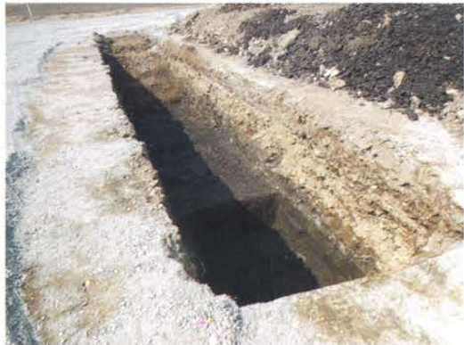
写真66 2 T 調査状況
