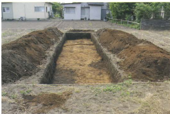
写真 131 2 T 調査状況
