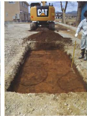
写真2 1T 調査状況
