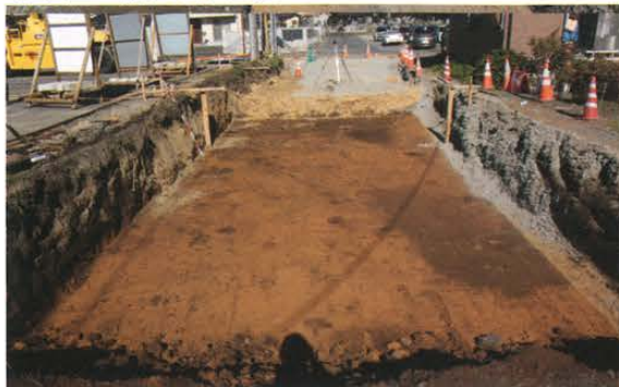
写真35 1 T 調査状況（2）
