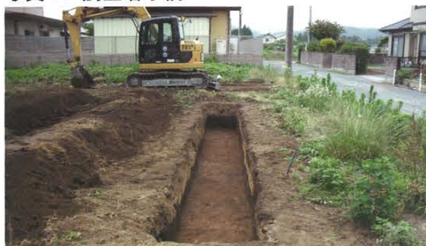
写真 82 1T 調査状況
