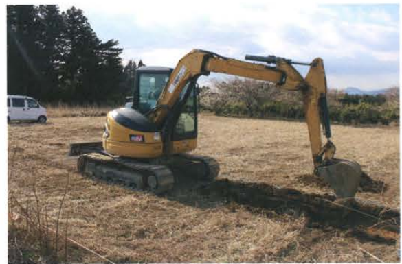
写真 77 重機掘削状況
