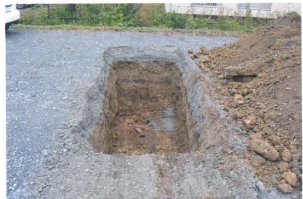
写真 72 2 T 調査状況
