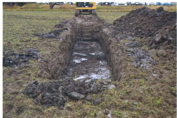
写真49 1 T 調査状況
