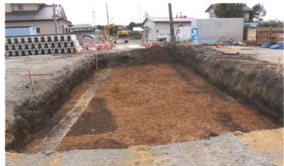
写真34 1 T 調査状況（1）
