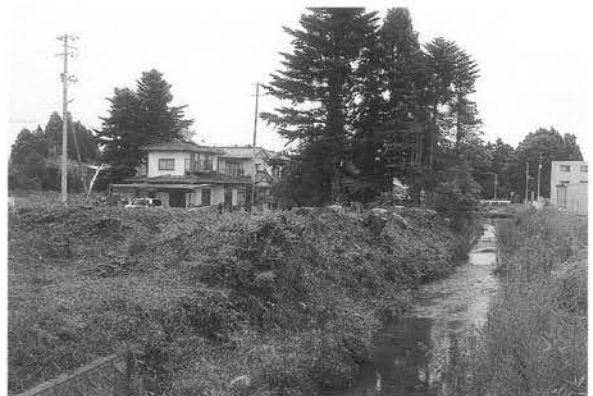
写5 土手2調査前現況
