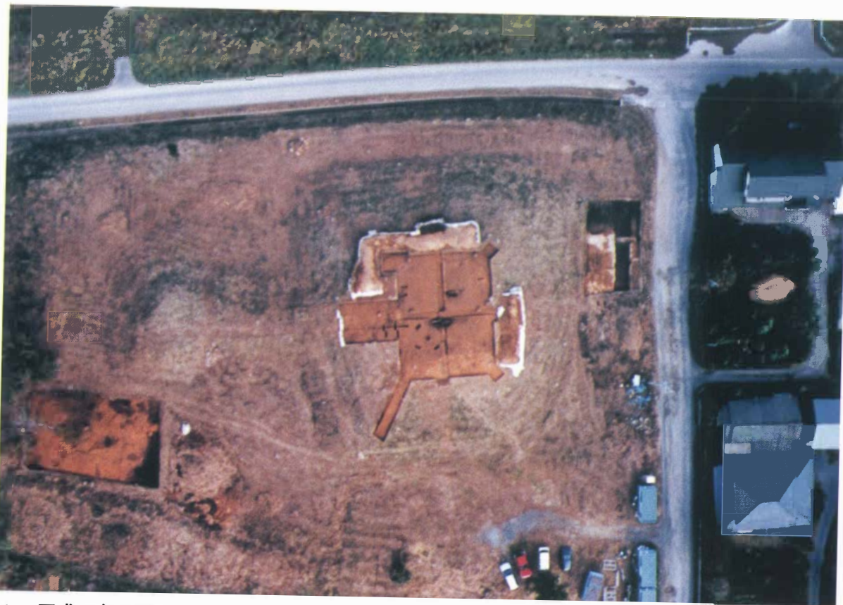
1 平成12年度調査状況 1 (真上から)
