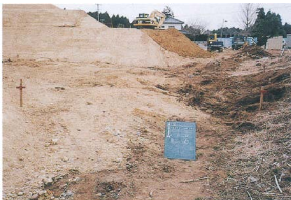
5 盛土造成工（盛土状況）
