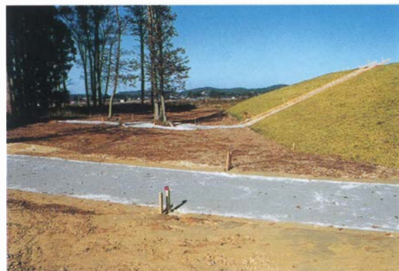
6 路盤工 (南側園路)
