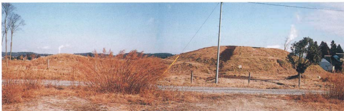
1 盛土造成工（施工前南から）
