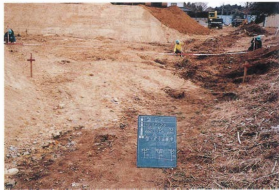
6 盛土造成工（客土搬入状況）
