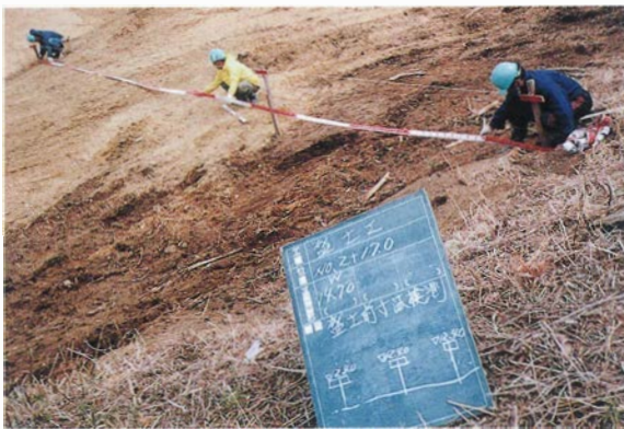
5 盛土造成工（丁張状況）
