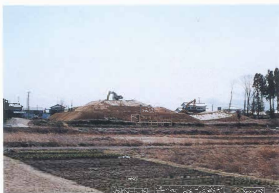
3 造成工事状況
