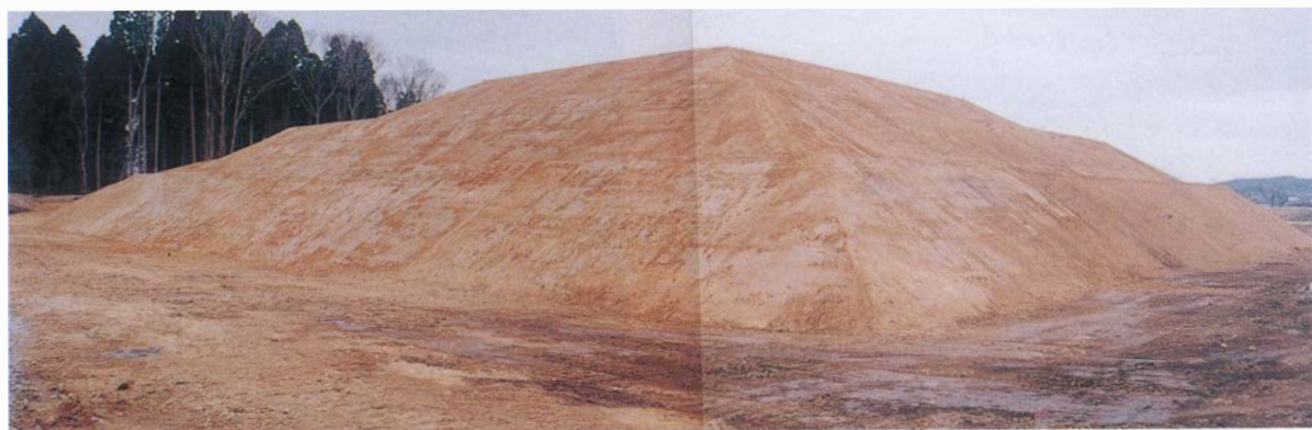
4 盛土造成工（施工後後方部）
