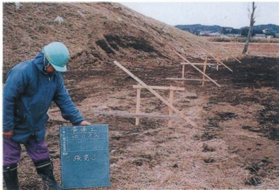
3 盛土造成工（丁張状況）
