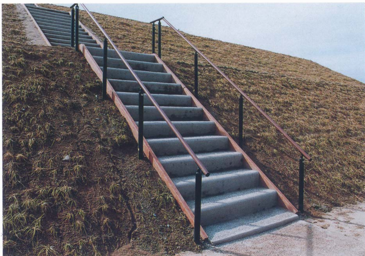
2 階段施工（手摺）
