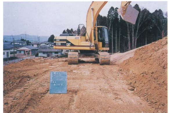
6 盛土造成工（盛土状況）
