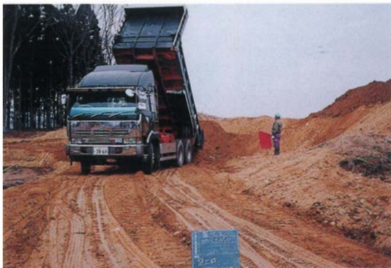
7 盛土造成工（客土搬入状況）
