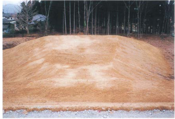
2 盛土造成工（後方部→前方部）
