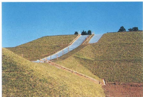
7 路盤工 (後方部西斜面)
