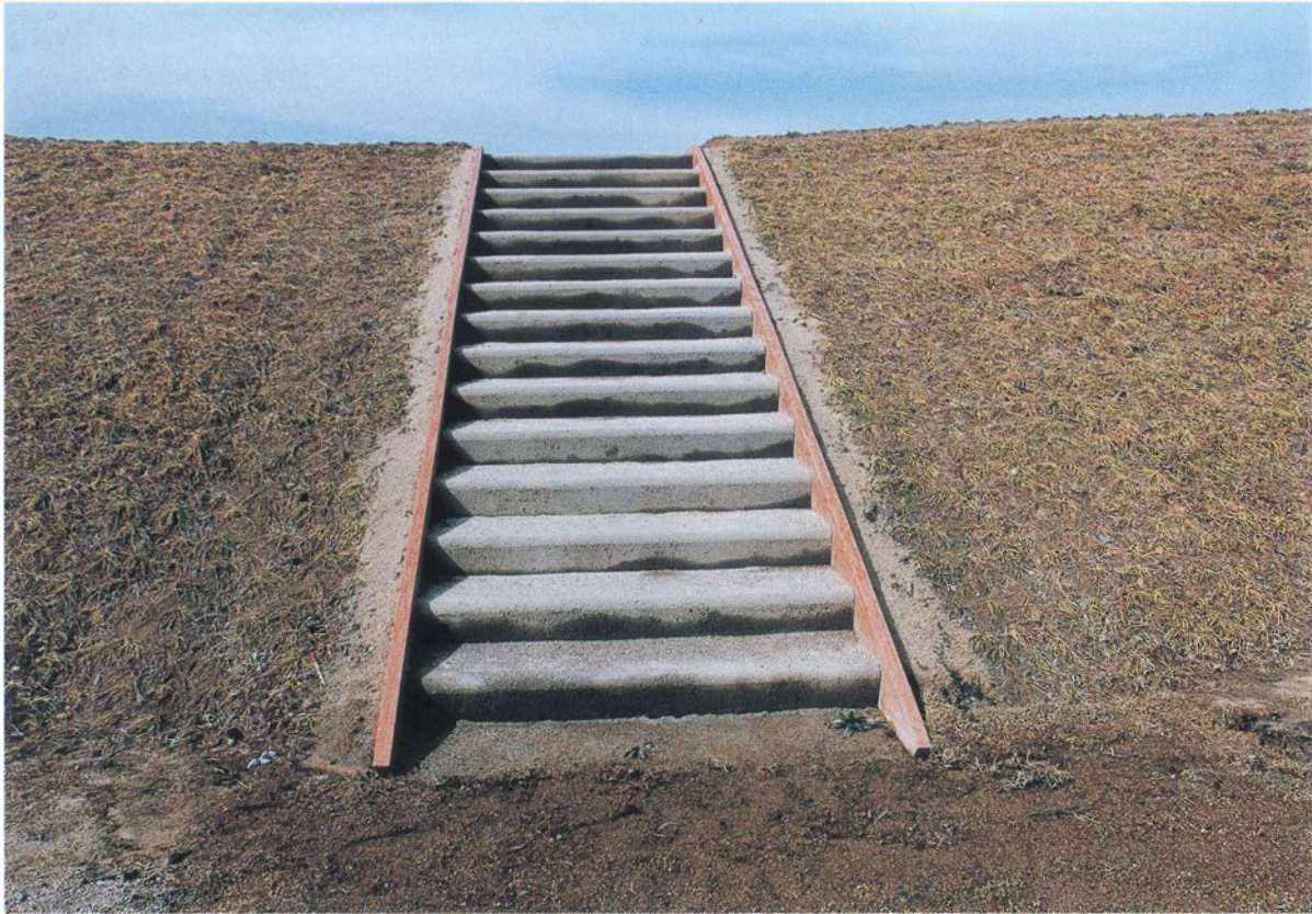
1 階段施工（前方部）
