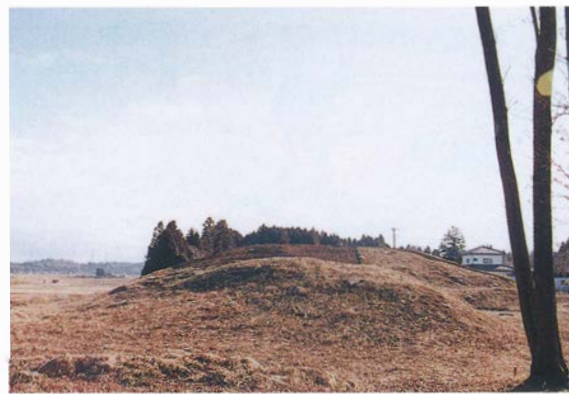
4 盛土造成工（施工前前方部）
