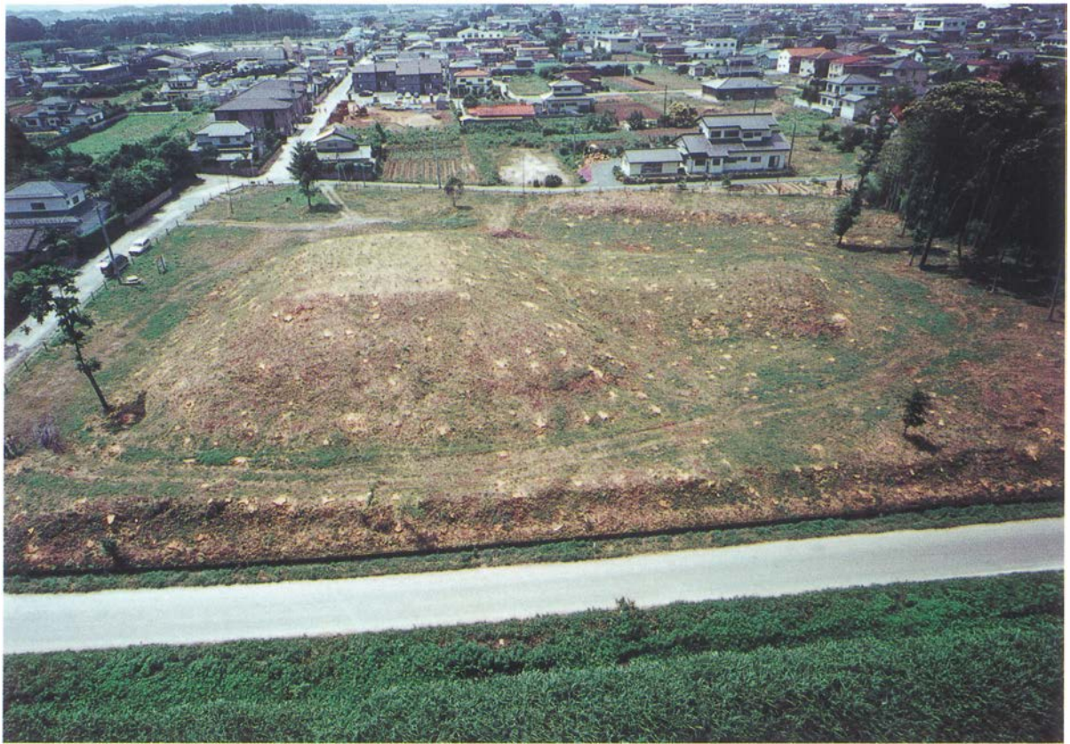
1 桜井古墳全景（北から）
