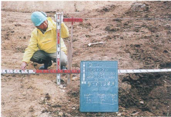
1 盛土造成工（盛土状況）
