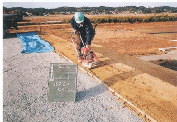
5 盛土造成工（後方部墳頂）
