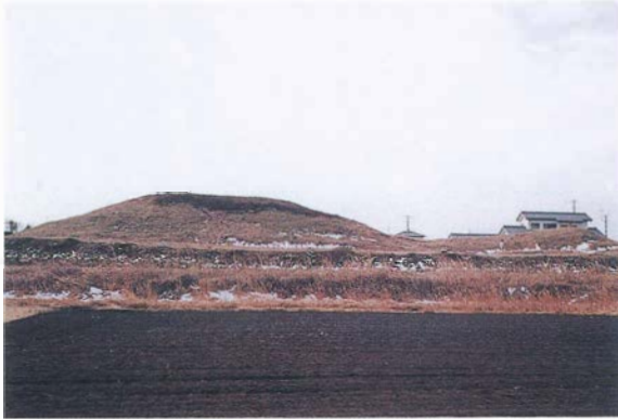
1 盛土造成工（施工前）
