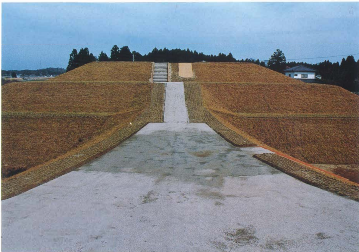
1 墳丘施工（前方部→後方部）
