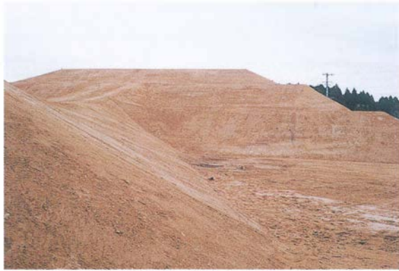
1 盛土造成工（前方部→後方部）
