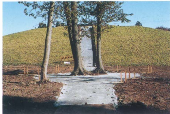
2 路盤工 (前方部西側広場)
