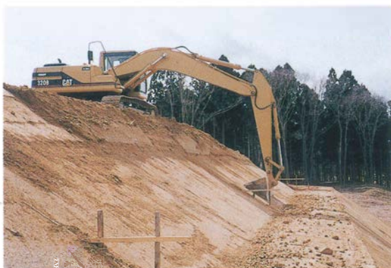
7 盛土造成工（法面整形）
