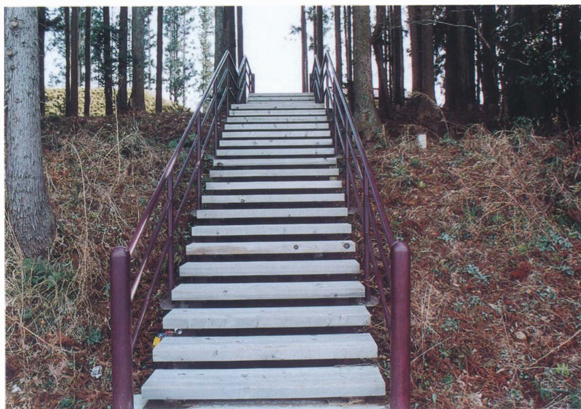
2 7号墳デッキ階段
