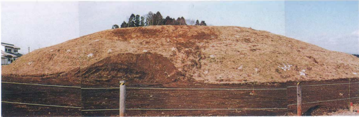
1 盛土造成工（施工前後方部）
