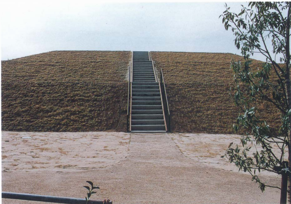
1 階段施工（後方部東側）
