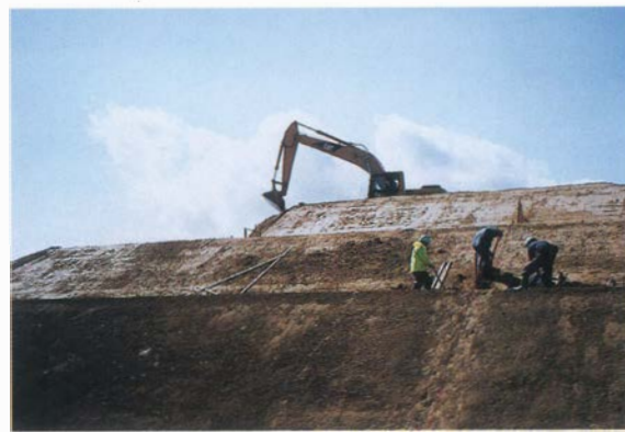
6 後方部造成状況
