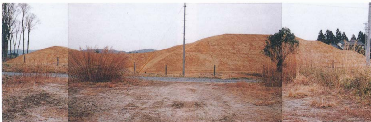
2 盛土造成工（施工後南から）
