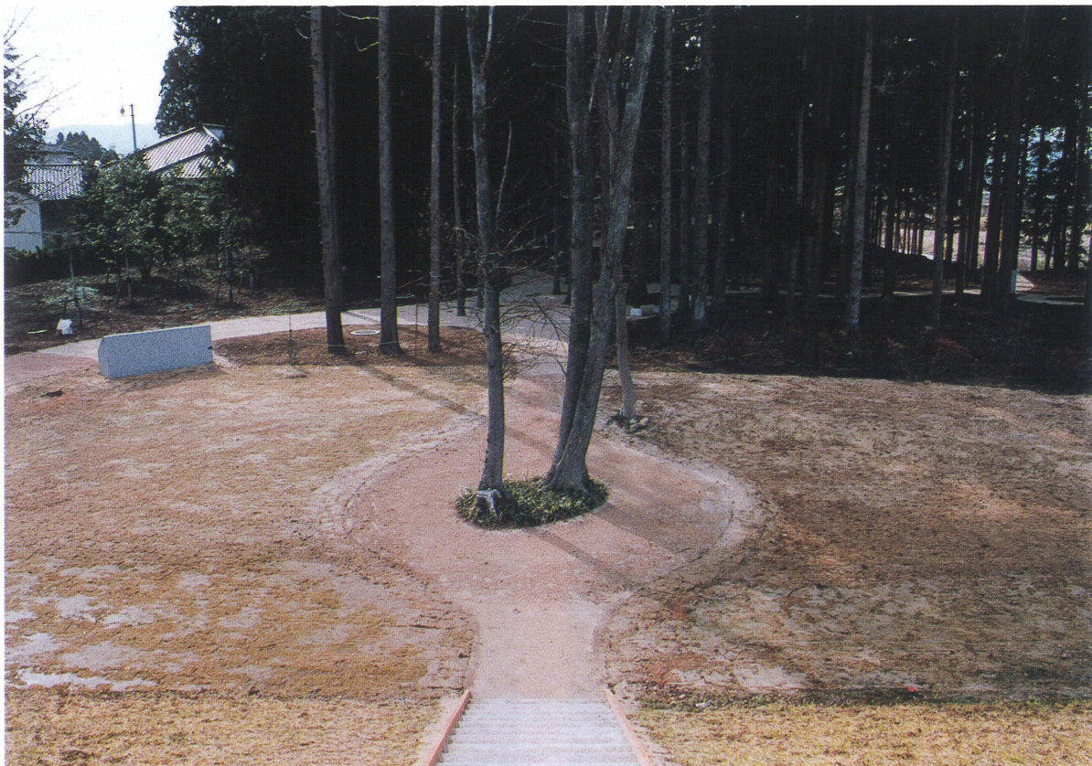
2 舗装（西側園路）
