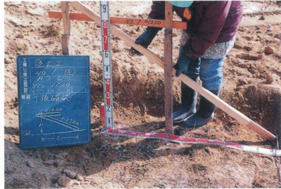
2 盛土造成工（丁張状況）
