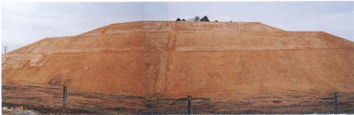
2 盛土造成工（施工後後方部）
