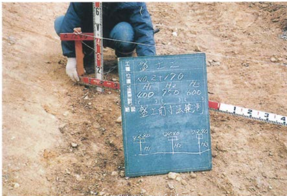
3 盛土造成工（盛土状況）
