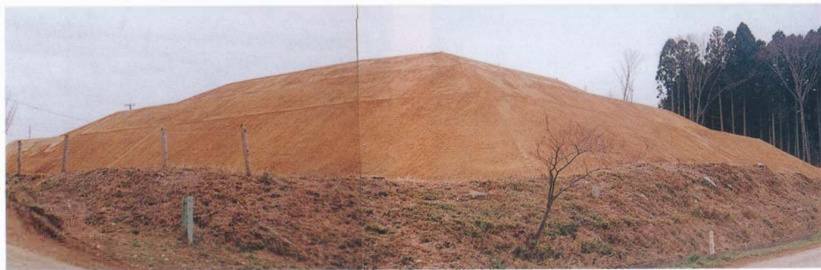
3 盛土造成工（施工後後方部）
