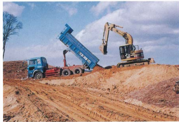
8 盛土造成工（客土搬入状況）
