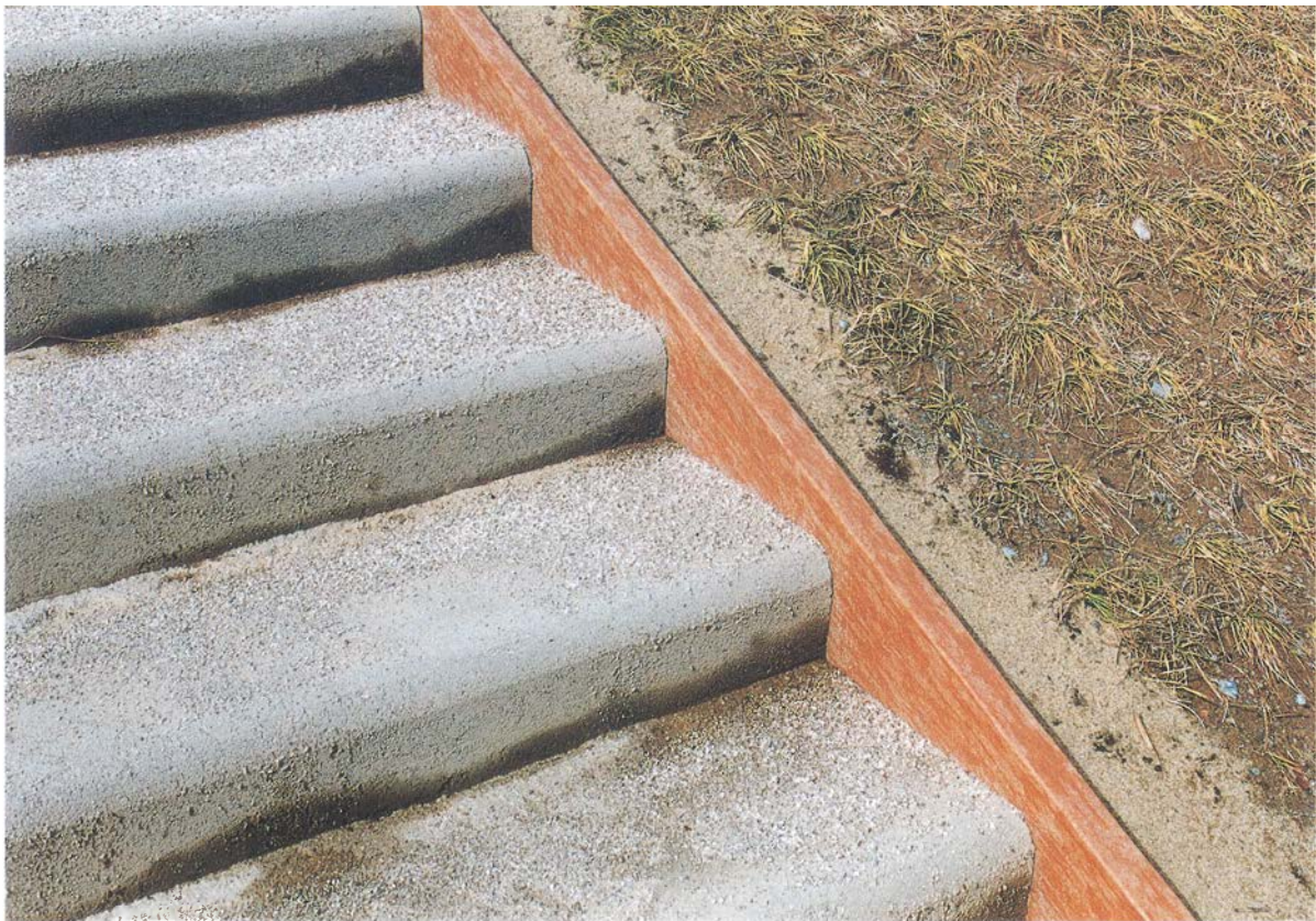
2 階段施工（前方部）
