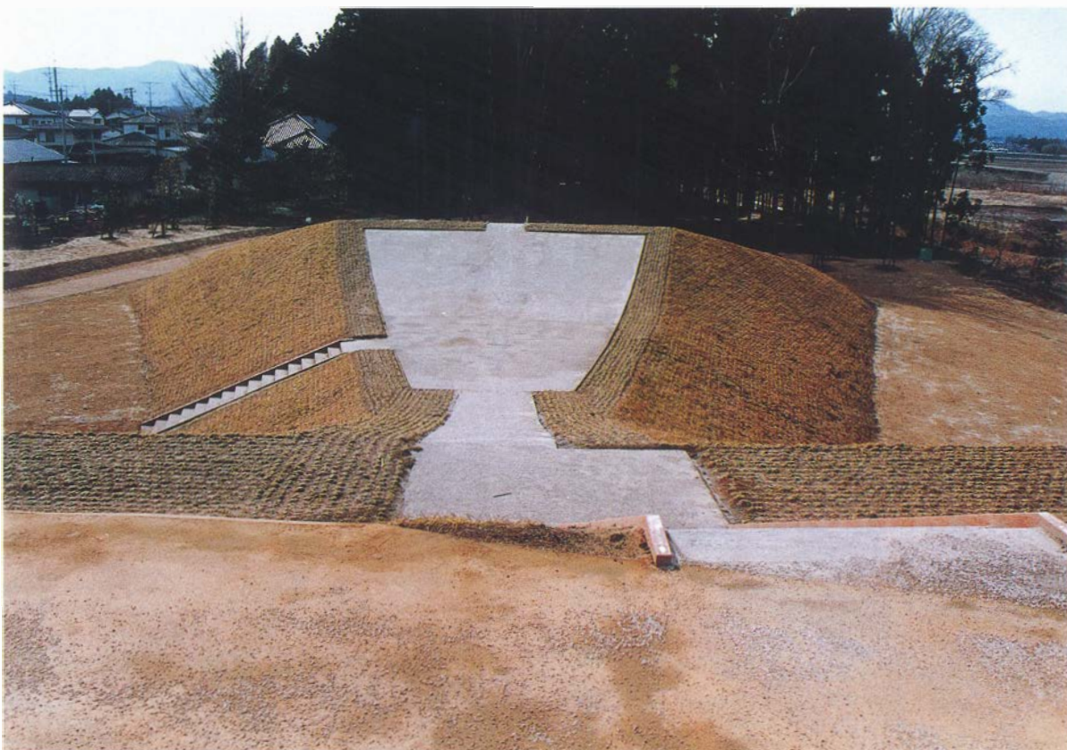
2 墳丘施工（後方部→前方部）
