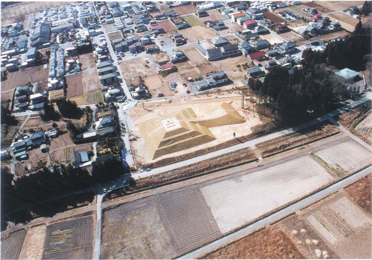
1 施工後空撮1 (北から)
