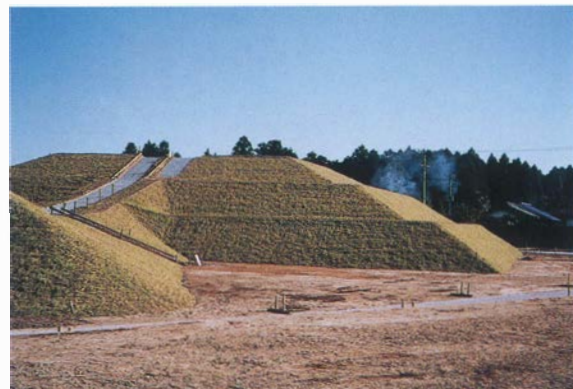
8 路盤工 (後方部・南側主園路)
