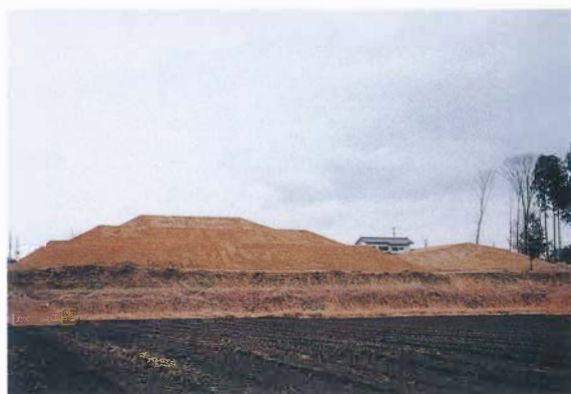
3 盛土造成工（施工後北から）
