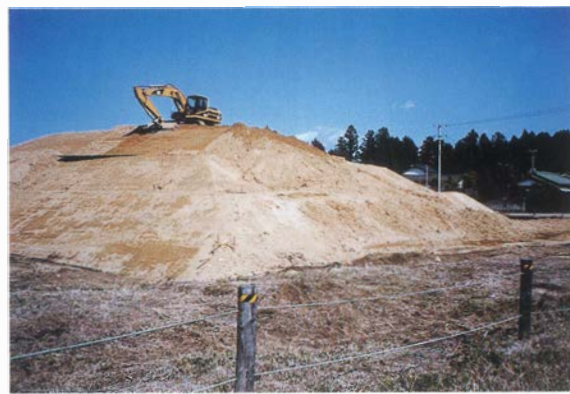
4 造成工事状況
