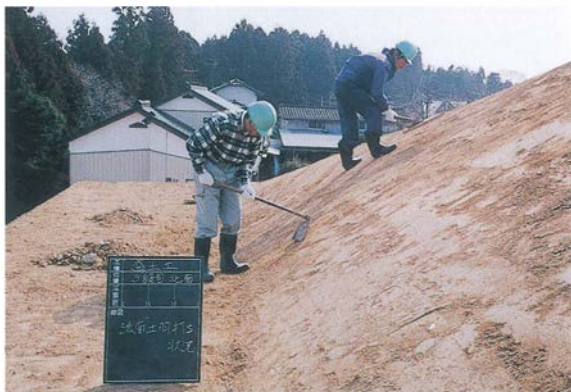
6 盛土造成工（斜面）
