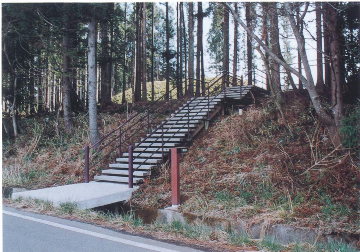
1 7号墳デッキ階段
