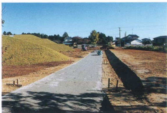
3 路盤工 (南側主園路)
