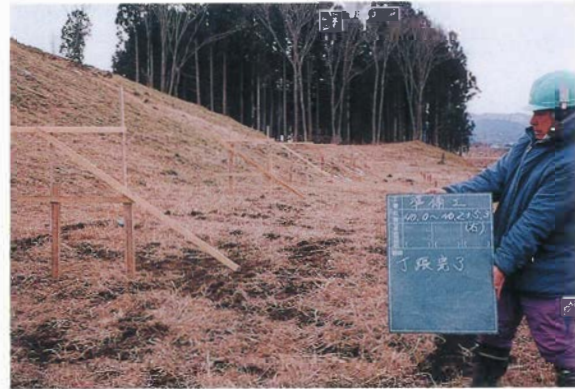
4 盛土造成工（丁張状況）
