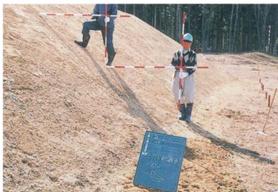
7 盛土造成工（斜面）
