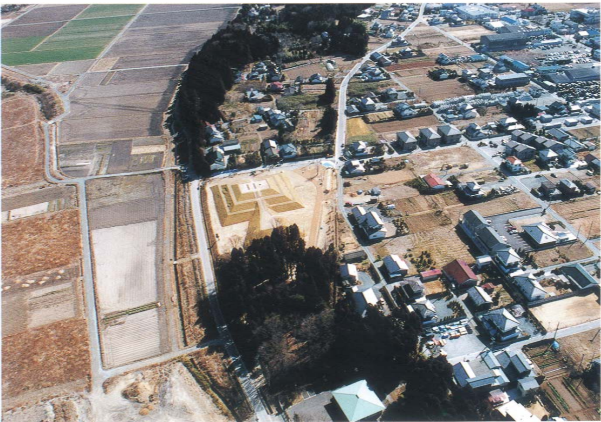
2 施工後空撮2 (西から)
