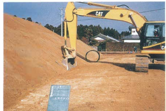
8 盛土造成工（法面整形）
