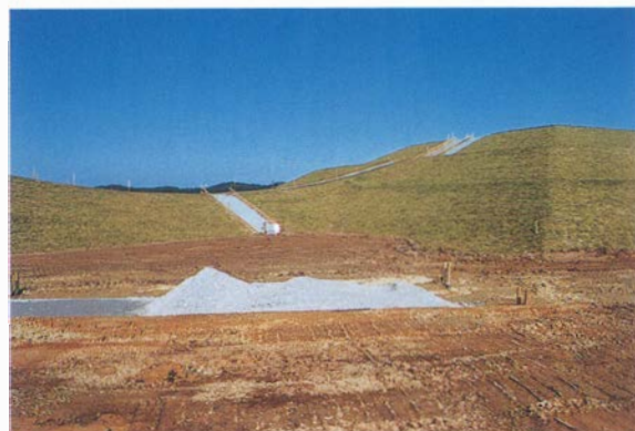
4 路盤工 (南側主園路)
