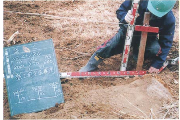
2 盛土造成工（盛土状況）
