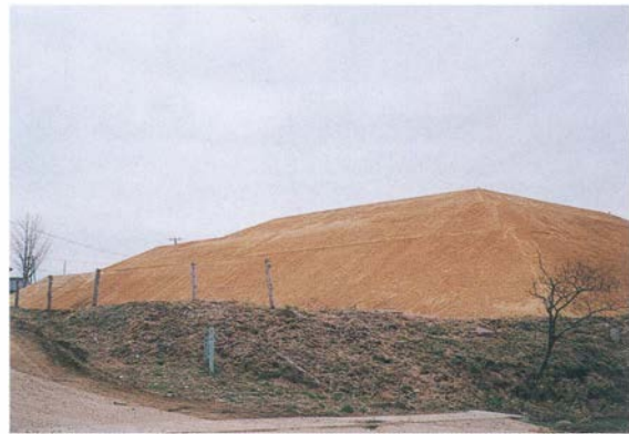
3 盛土造成工（後方部）
