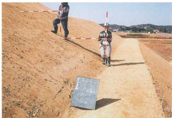
8 盛土造成工（斜面）
