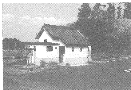
搦手側駐車場内トイレ
