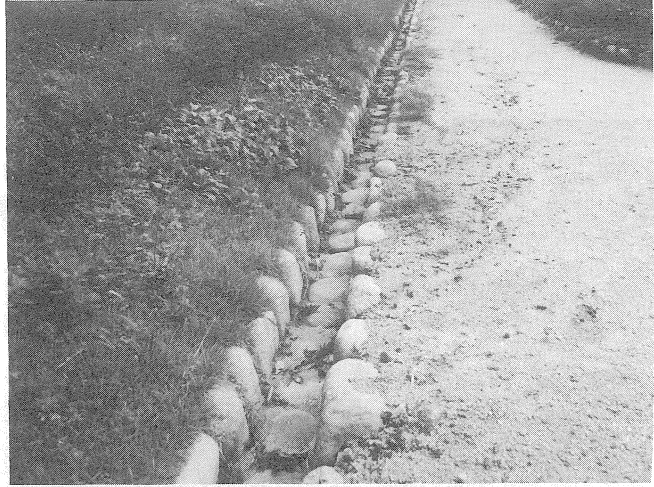
石積みによる側溝 (参考写真：足助城)
