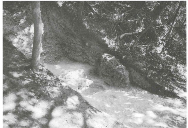
平成19年度 No.9地点 完掘状況（西から）
