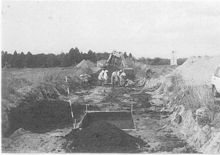
重機による表土剥ぎ
