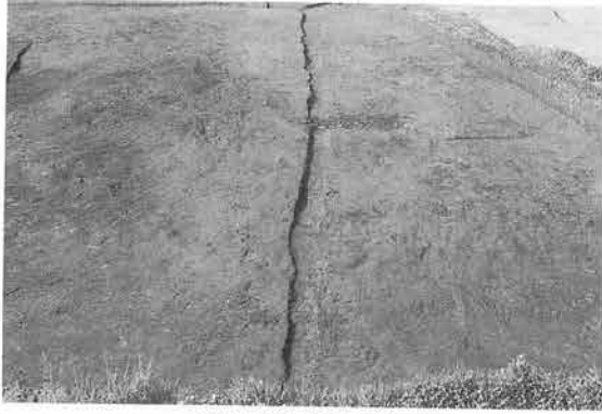
RG095完掘(南から)
