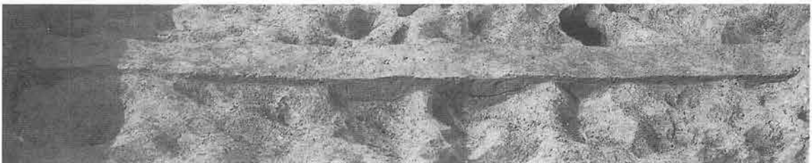
貼り床断面(南東から)
