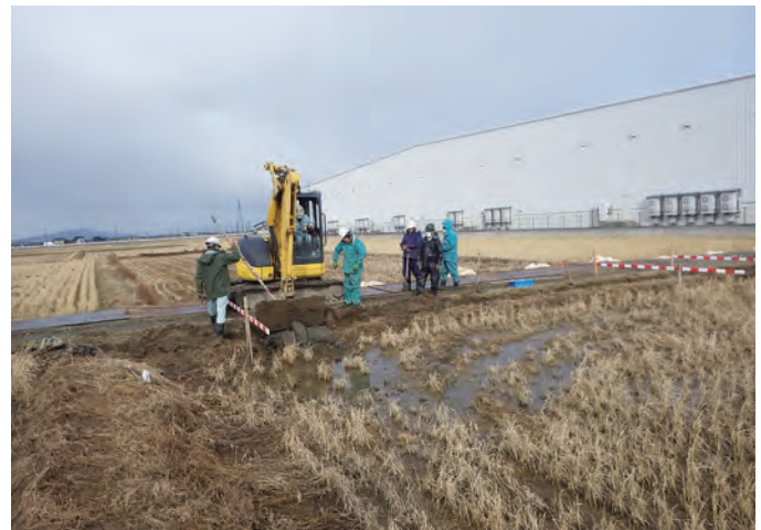
4 トレンチ 調査風景（南東から）
