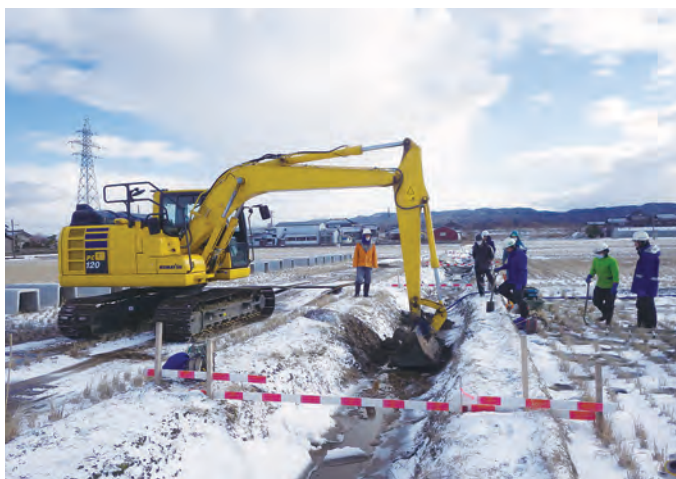
2 トレンチ 調査風景（西から）
