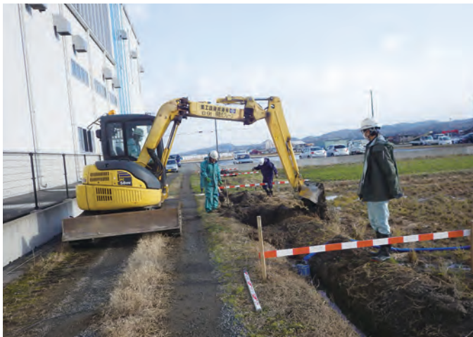
2 トレンチ 調査風景（南西から）
