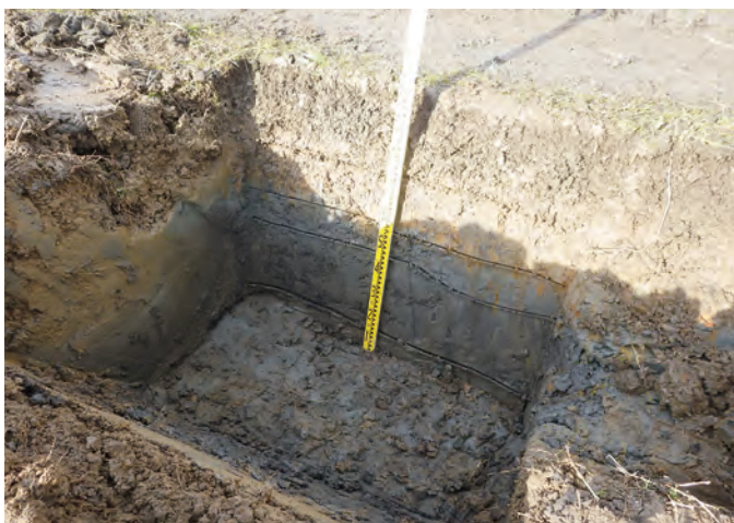
3 トレンチ 土層断面（東から）
