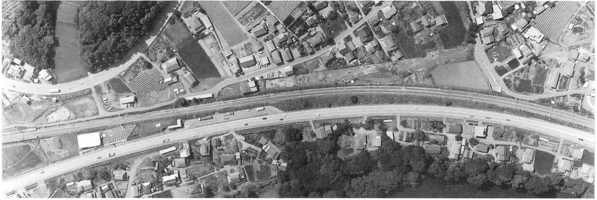
調査区南端～中央部全景（東上空から）
