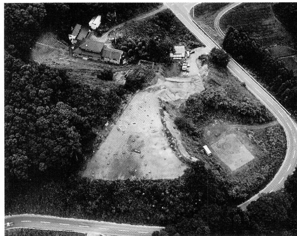
左写真A地点から見た調査区（北から撮影）
