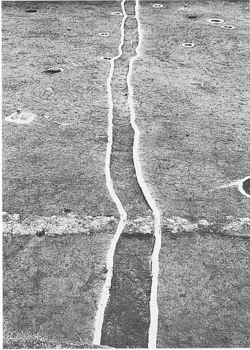
RG280溝跡完掘（西から）
