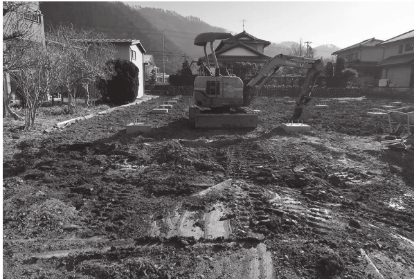
3 調査前（西から）
