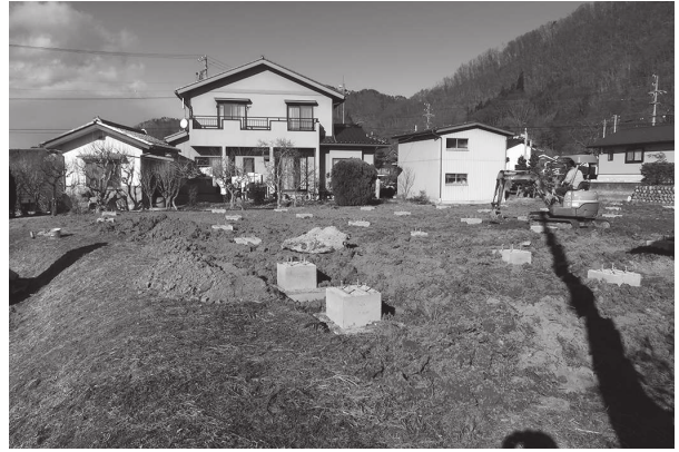
2 調査地近景（南西から）
