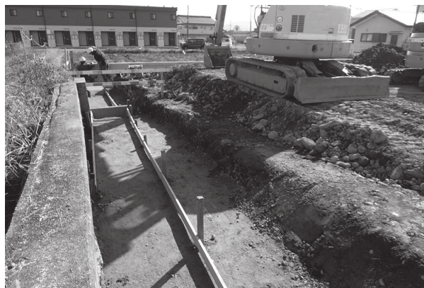
2 北辺擁壁施工状況（西から）
