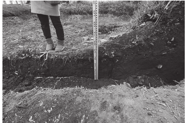
4 ②トレンチ南壁（杭部分）
