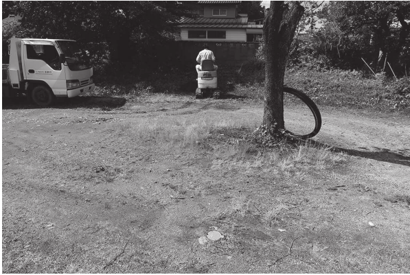
1 ①施工状況（北から）
