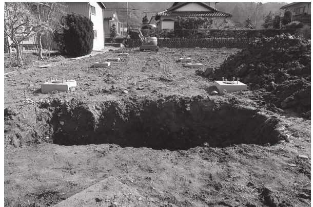
6 トレンチ完掘（西から）
