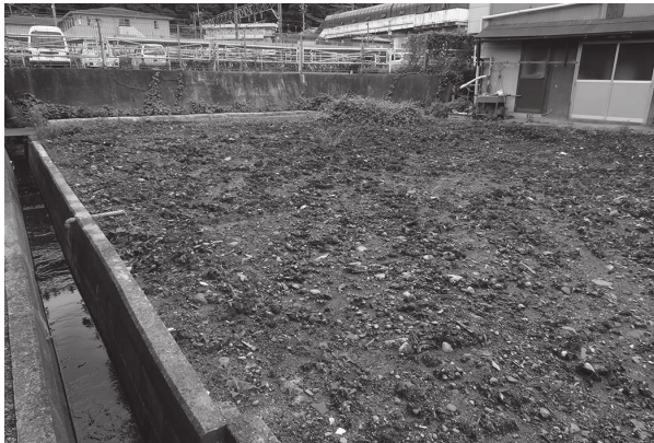
1 調査前（北西から）
