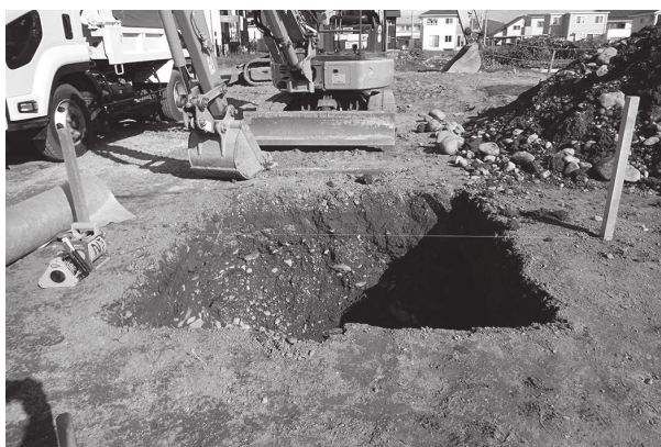
3 浸透柵施工状況（南から）
