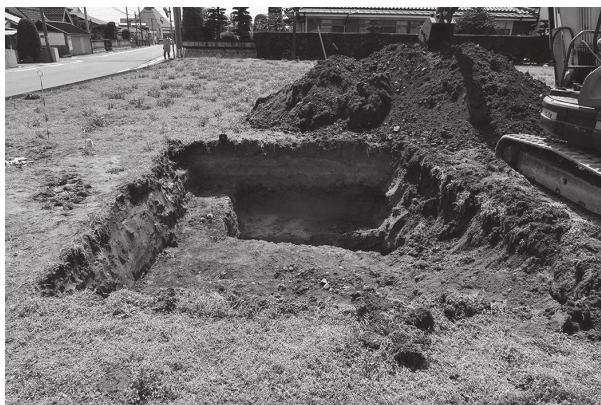
3 トレンチ完掘（北から）
