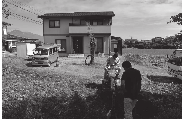
2 ①施工状況（南から）
