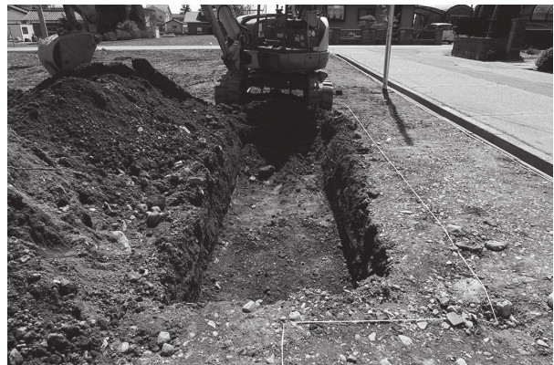
2 Cトレンチ完掘（北から）
