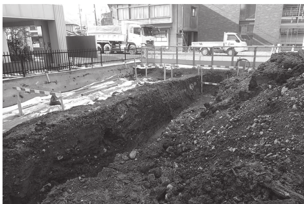
7 工事立会掘削（北東から）
