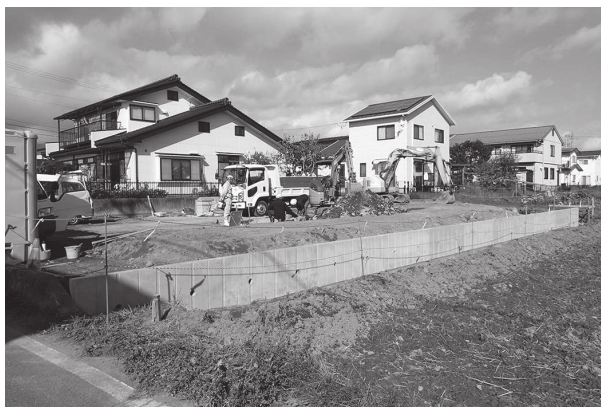
1 施工地近景（南東から）
