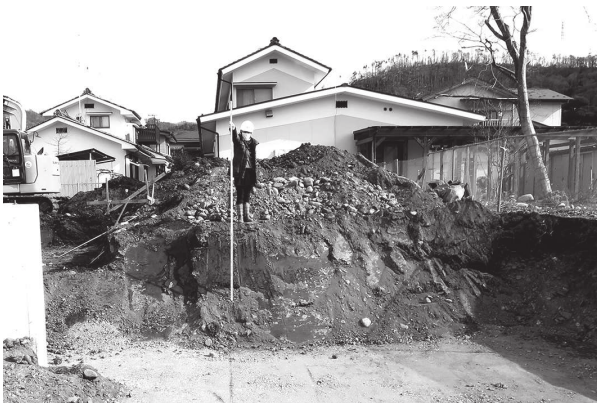
3 地下室掘削遠景（西から）
