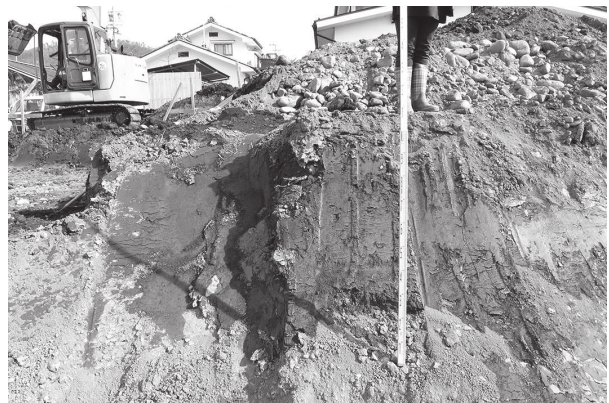
4 地下室掘削近景（西から）
