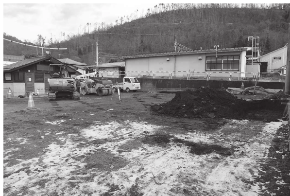
2 調査地近景（南西から）
