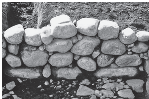
西壁 石積み（東から）
