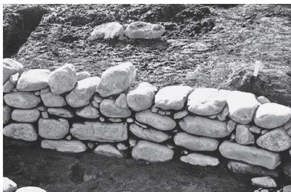
西壁 石積み（東から）
