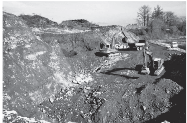
造成による段丘掘削状況（南西から）
