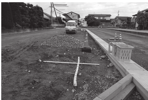
6 Bトレンチ調査前（北から）
