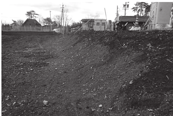
3 切土（北西から）
