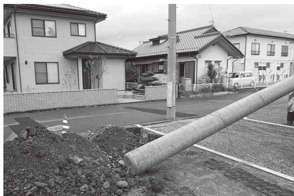
1 施工状況（南東から）
