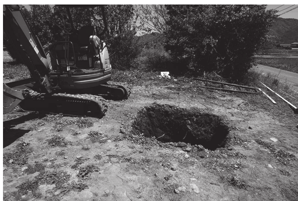
4 Bトレンチ完掘状況 (西から)
