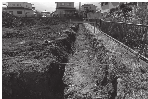
6 東西トレンチ（東から）
