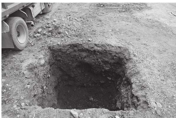
6 Cトレンチ完掘状況 (西から)
