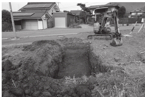
4 トレンチ完掘 (南から)
