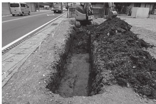
5 完掘状況 (南から)
