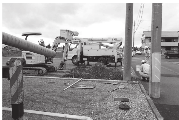
2 施工状況（北から）
