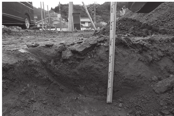
2 基礎掘削東壁
