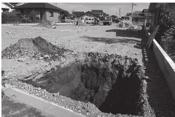
3 Aトレンチ完掘 (南東から)
