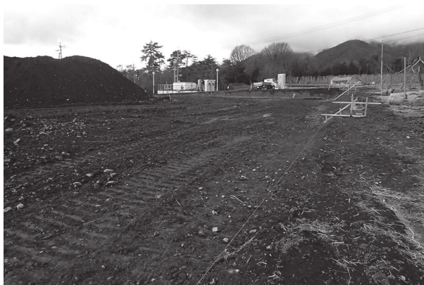
5 調査地近景（北東から）
