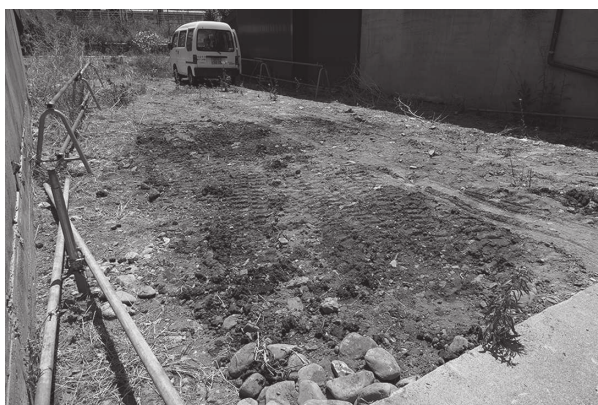
8 埋戻し後（北西から）
