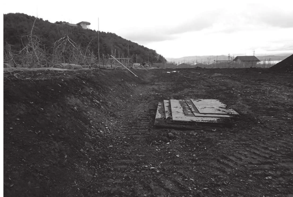
4 切土（南西から）
