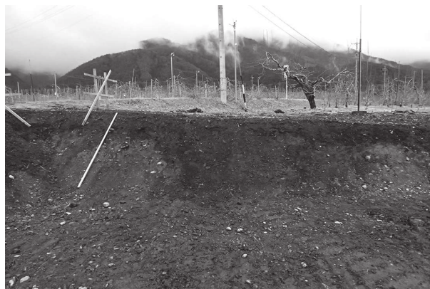
2 切土（南東から）
