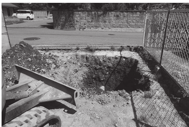
7 Cトレンチ完掘 (南から)
