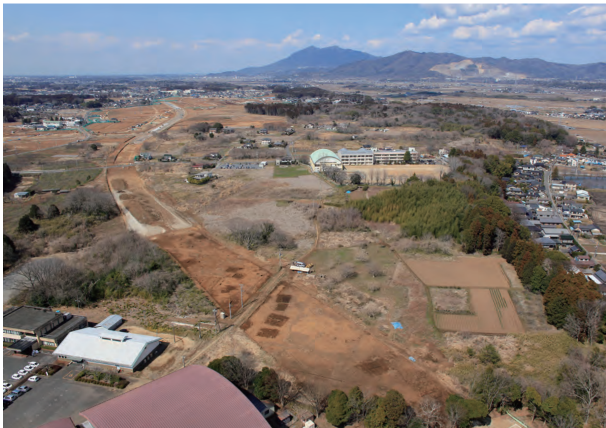
平成28年度調査区遠景（南から）
