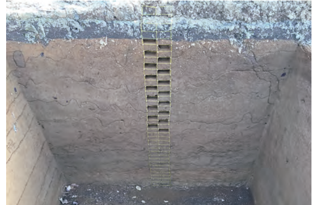
テストピット1 分析用試料土壌採取状況
