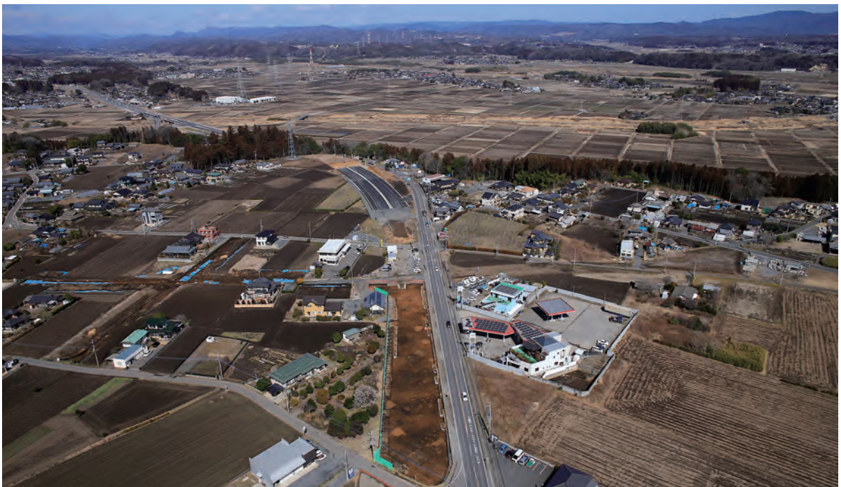
平成29年度調査D区全景（南部から）
