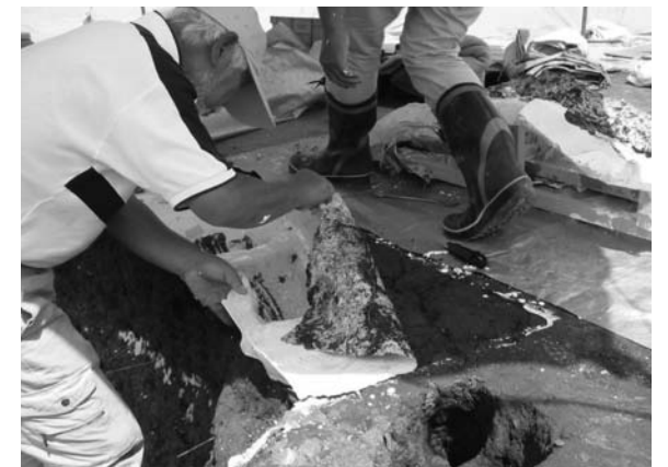
写真10 脱型作業状況
