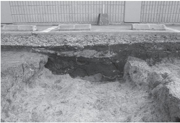
① 5号溝 A-A' ベルト土層断面 (北側から)
