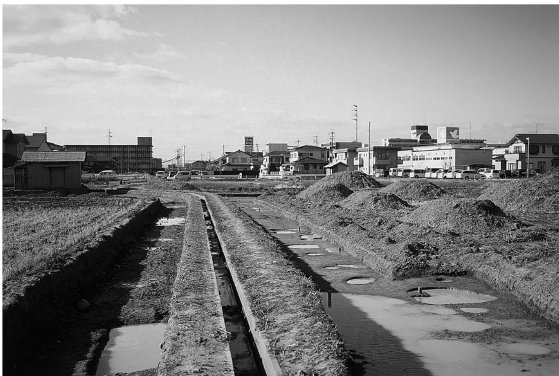
2 2区・3区全景（東から）
