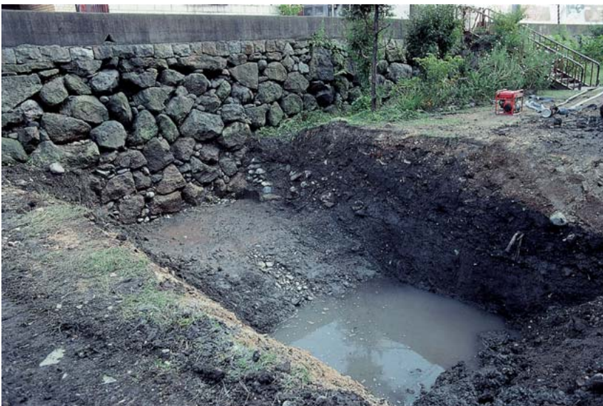
第94次調査 南壁（北西から）
