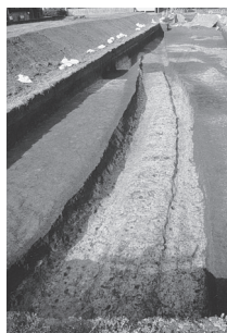
⑦4号溝完掘 （南側から）
