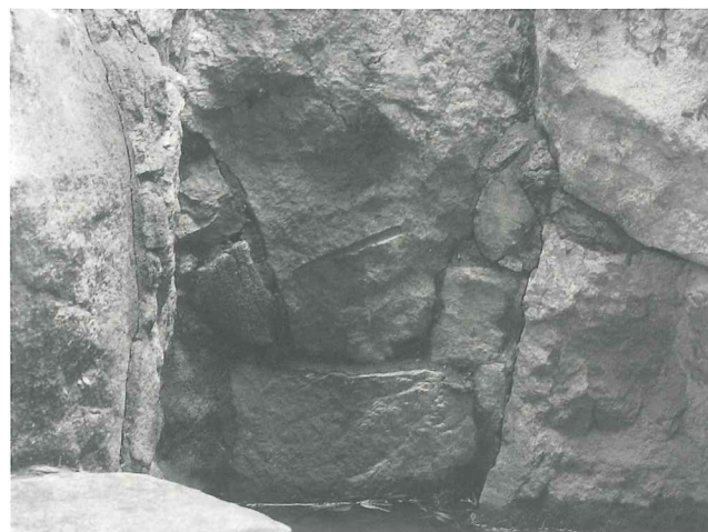
写真17 滝石組みに残る削岩ドリル痕
