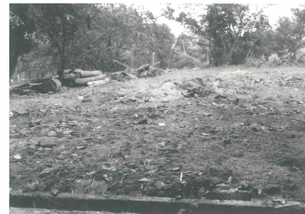
写真10 南のくら解体後の様子(昭和41年頃)
