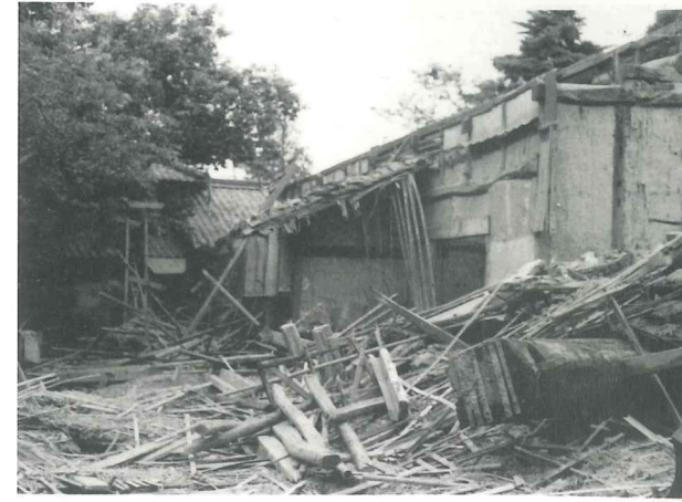
写真43 解体される南のくら(昭和41年)
