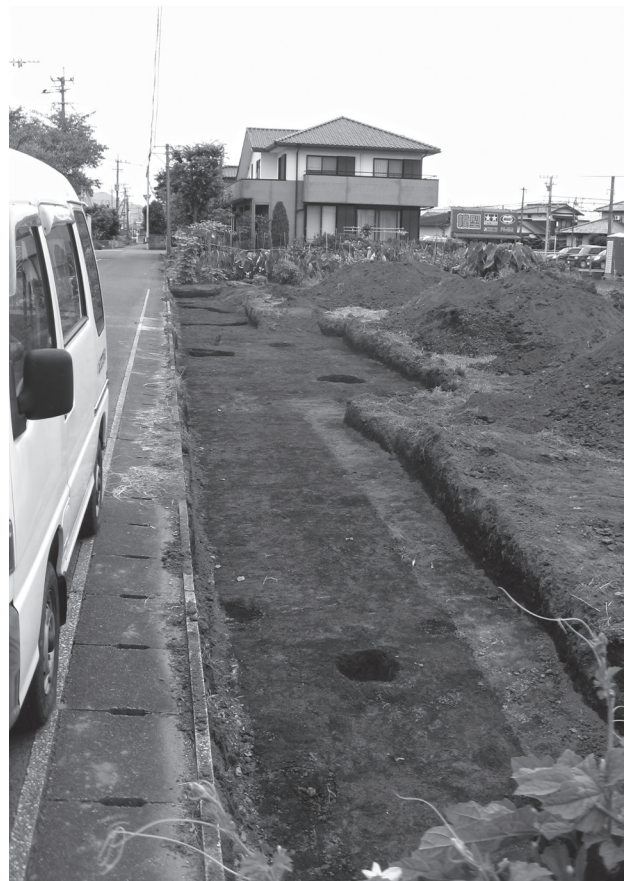
⑥4トレンチ 全景 (2) (南西から)
