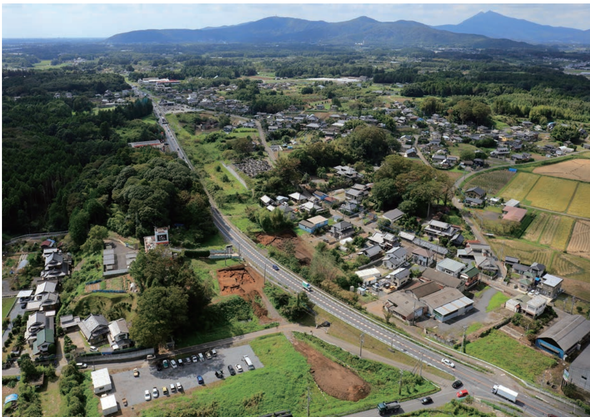
調査区遠景（東方向から）
