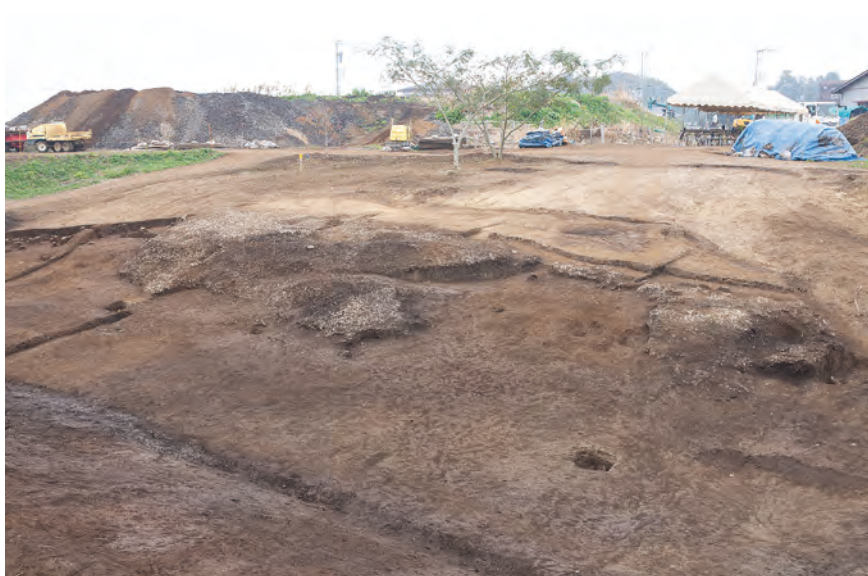
第4・12号斜面具層 確認状況④(南から)
