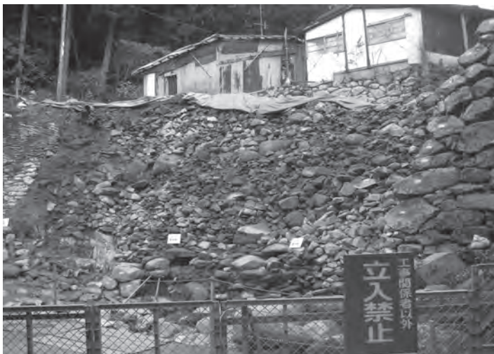
写真1 石垣裏込めの状況(筆者撮影)
