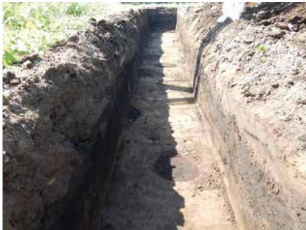
写真17 三口遺跡1トレンチ（北から）
