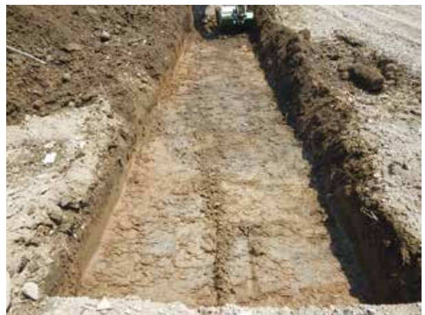
写真 11 中津城下町遺跡① 2 トレンチ (南から)
