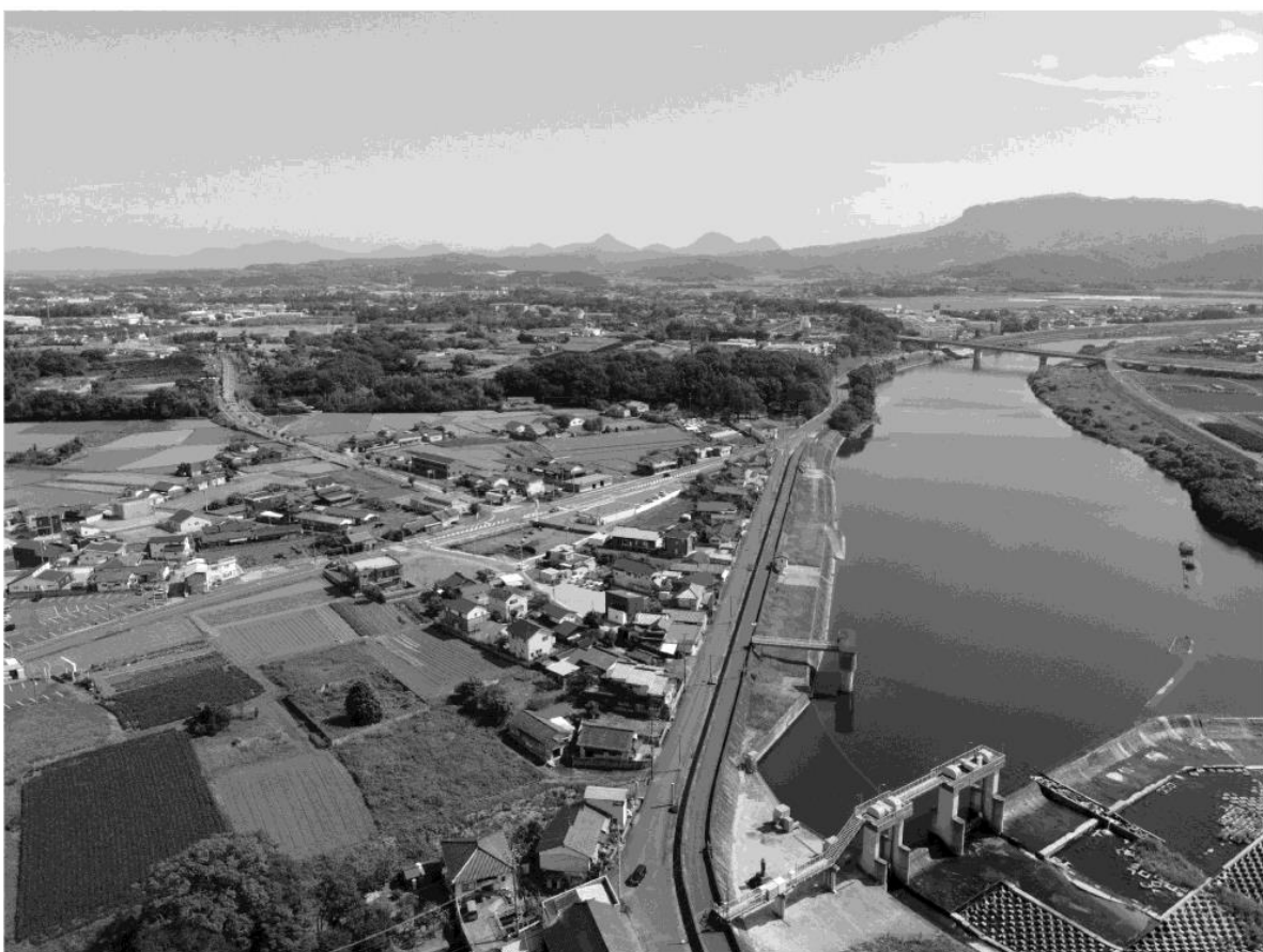
遺跡遠景（北西から）
