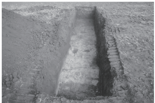
写真166 トレンチ3掘削状況(南から)
