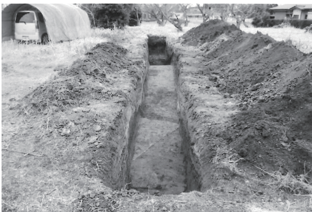
写真 152 トレンチ 1 掘削状況（西から）
