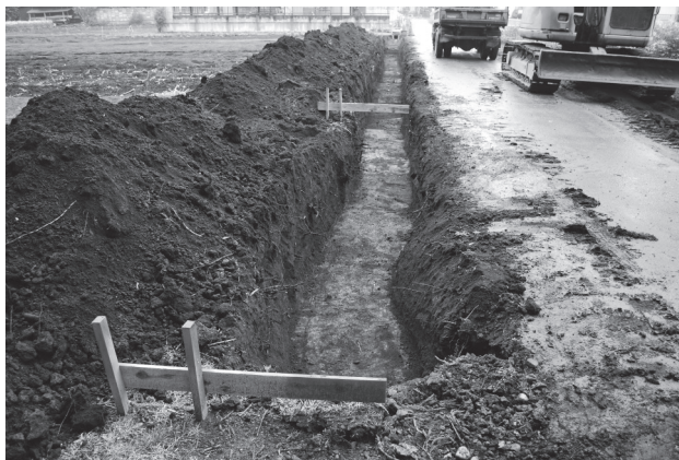
写真 17 トレンチ 1 掘削状況 (東から)
