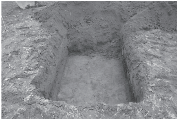
写真164 トレンチ1掘削状況(西から)
