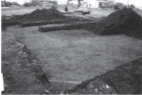
写真 144 トレンチ 2 全景 (南西から)
