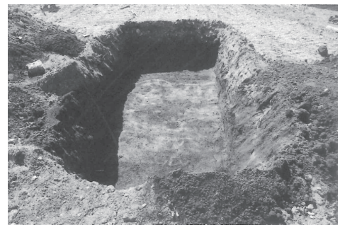
写真133 トレンチ掘削状況（東から）
