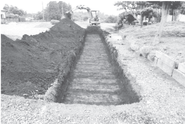
写真 84 トレンチ掘削状況（東から）
