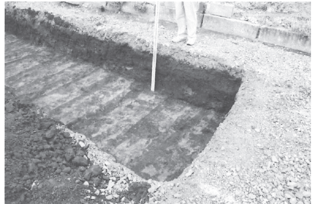
写真 85 トレンチ掘削深度（南東から）
