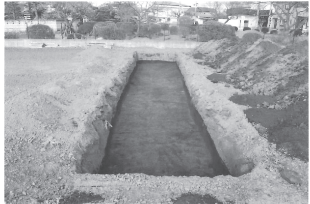
写真 107 トレンチ 3 掘削状況 (南から)
