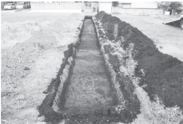
写真92 第1次調査トレンチ掘削状況（西から）
