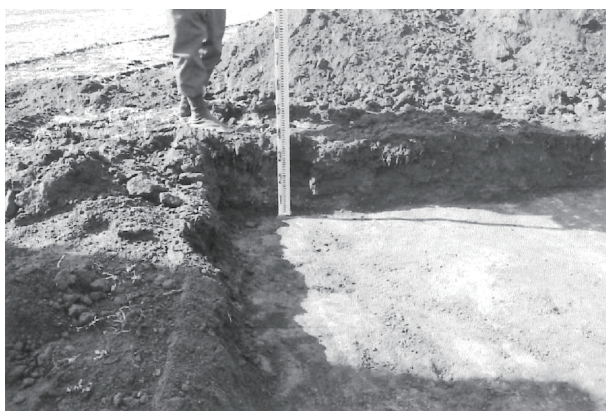
写真 161 トレンチ 3 掘削深度 (東から)
