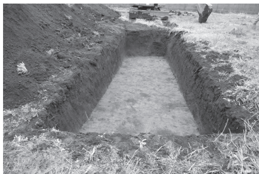
写真79 トレンチ1掘削状況（南から）
