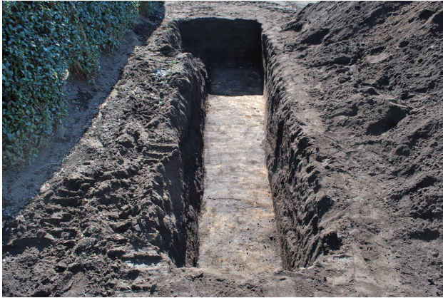
写真 73 トレンチ 3 掘削状況 (北から)
