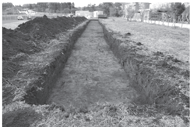
写真6 トレンチ2 掘削状況 (南から)
