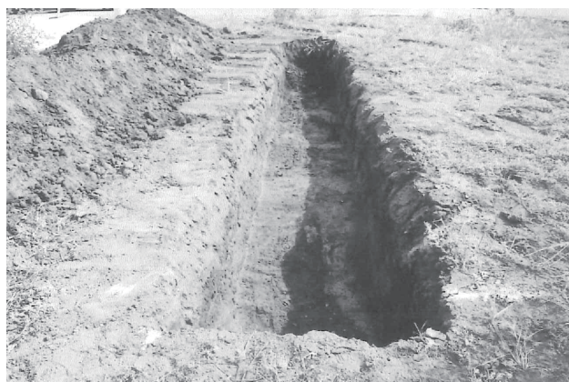
写真125 トレンチ1掘削状況(北から)
