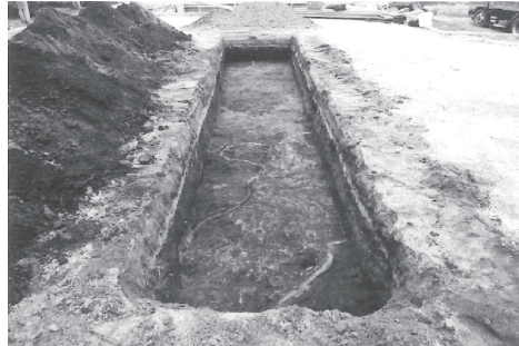
写真139 Eトレンチ掘削状況（南東から）
