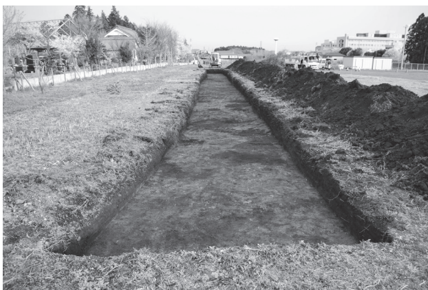
写真5 トレンチ2 掘削状況 (北から)
