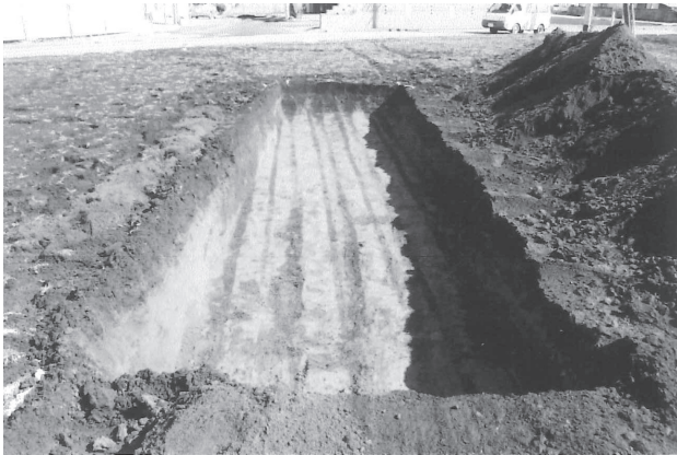
写真 129 トレンチ 2 全景 (西から)
