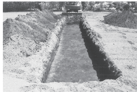
写真 131 トレンチ 1 掘削状況（西から）
