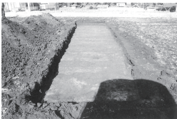
写真 160 トレンチ 3 掘削状況 (南から)
