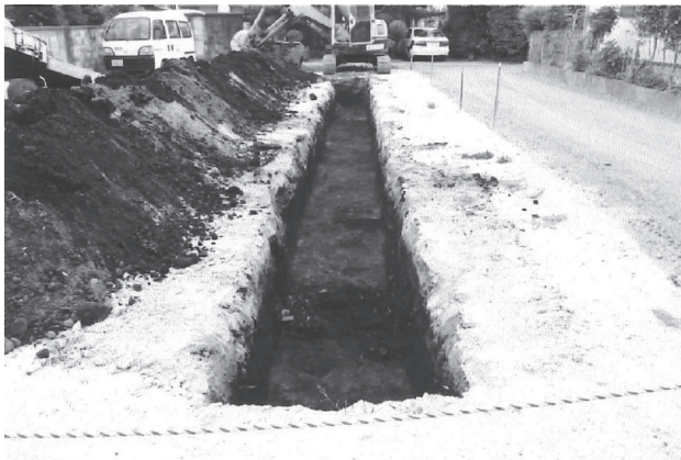
写真 45 トレンチ掘削状況（西から）
