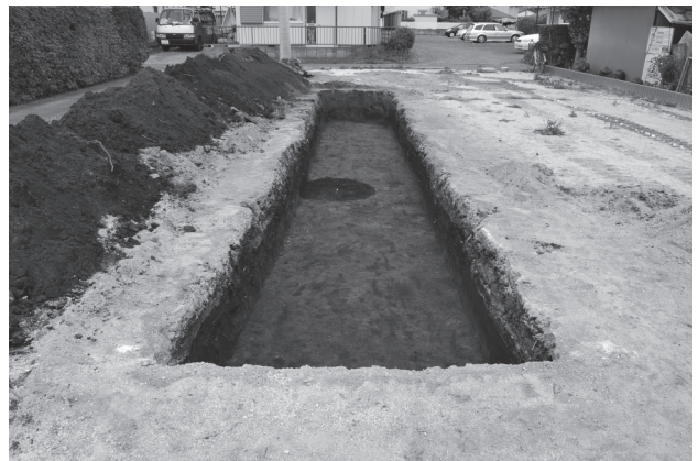
写真 16 トレンチ 2 掘削状況 (東から)
