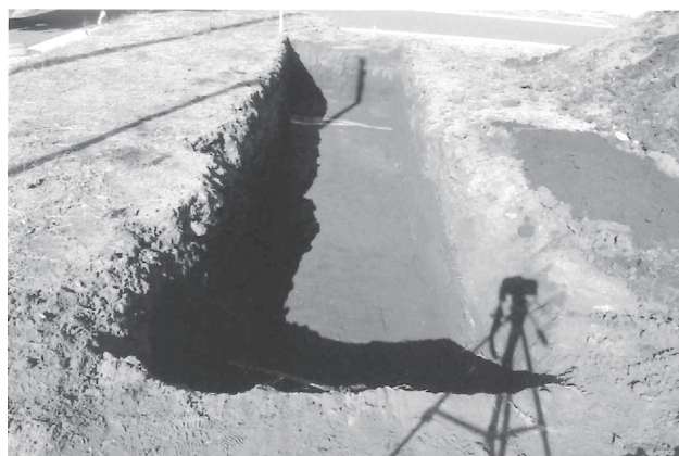
写真 115 トレンチ 1 竪穴建物跡検出状況 (南東から)
