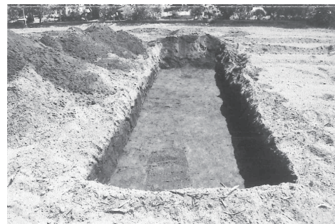
写真 132 トレンチ 2 掘削状況（西から）
