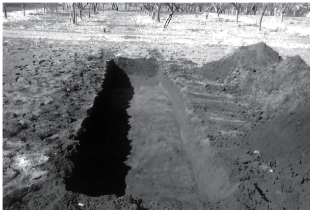
写真149 トレンチ1掘削状況（東から）
