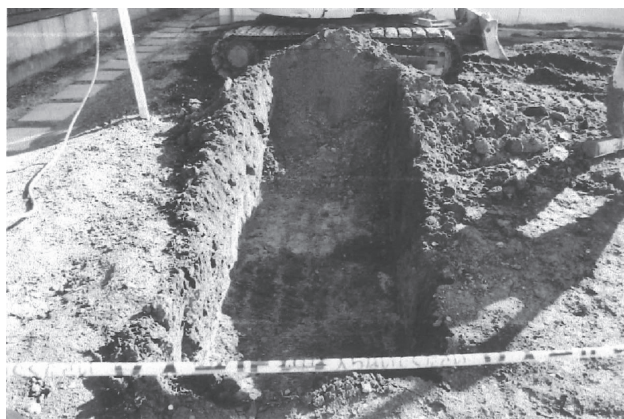
写真83 トレンチ1掘削状況（西から）
