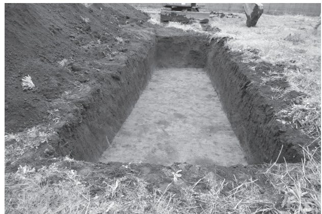
写真12 トレンチ1掘削状況（北東から）
