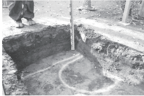
写真147 トレンチ2掘削深度(南東から)
