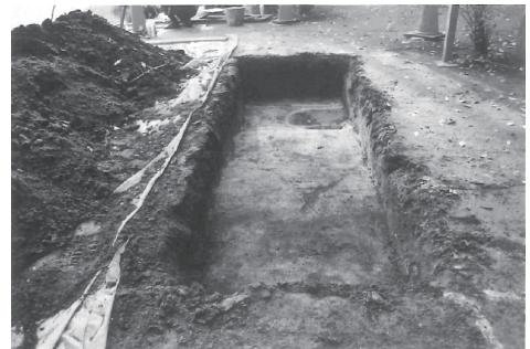
写真 146 トレンチ 2 掘削状況 (東から)
