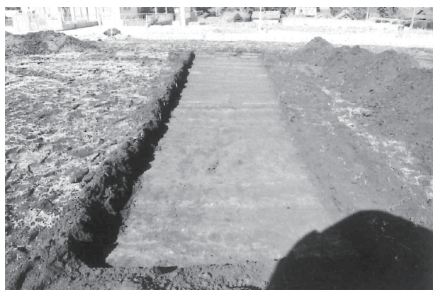
写真 162 トレンチ 4 掘削状況 (南から)
