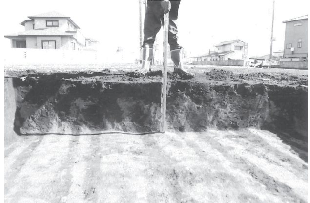
写真 128 トレンチ 1 掘削深度 (西から)
