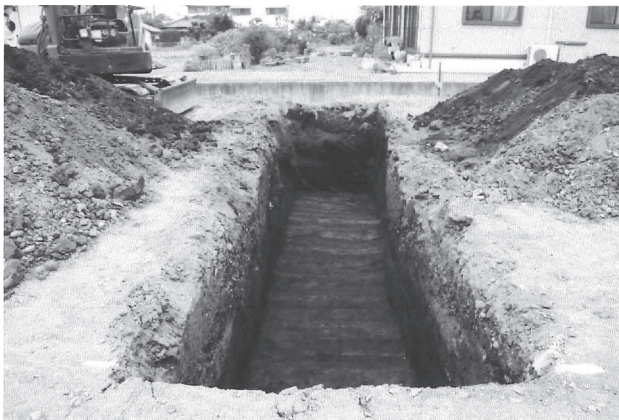
写真47 トレンチ1掘削状況（東から）
