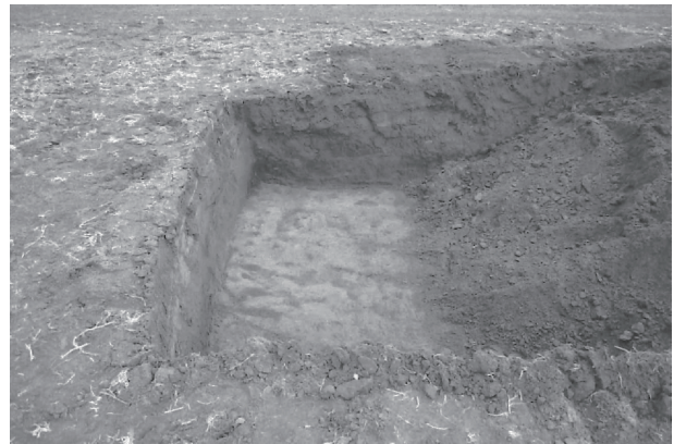
写真165 トレンチ2掘削状況(南から)
