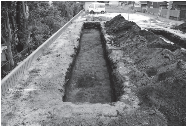
写真 15 トレンチ 1 掘削状況 (西から)
