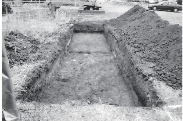
写真 155 トレンチ 3 掘削状況 (北から)
