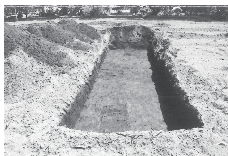
写真134 竪穴建物跡検出状況(東から)
