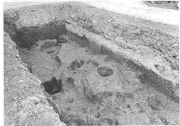
写真128 第9トレンチ 西端 (南東から)
