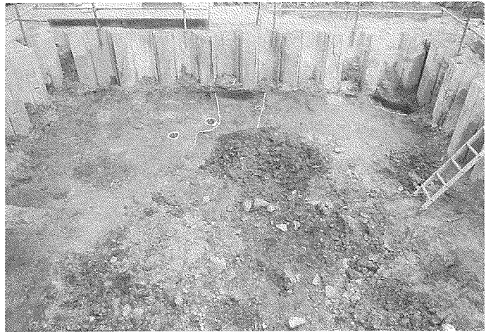
写真5 J3区全景(西から)
