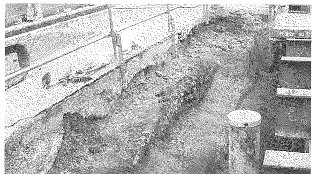
写真4 灰原完掘状況
