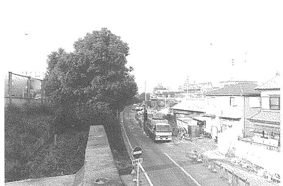
写真 14 5 次 J4 区付近から西を見る
