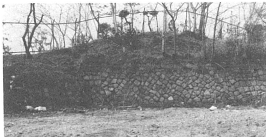
第7図 石垣屈折部構築状況
