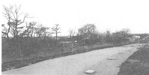
第2図 南台場東側石垣と道路建設予定地
