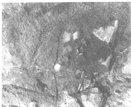
第11図 石垣最下段グリ充填状況
